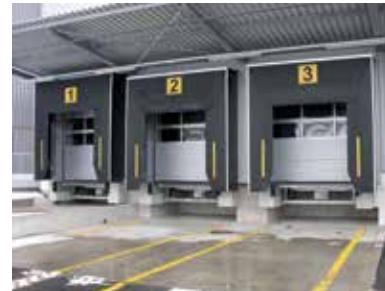
Moderner Güterumschlagplatz mit Andockkrampen
