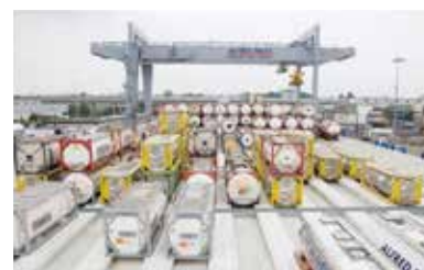
Stand der Technik bei der Containerlagerung: Auffangwanne und Containerterminal TALKE in Hürth/Köln.
