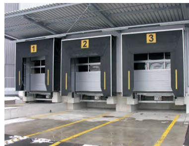
Moderna piazza di trasbordo merci con tunnel di carico
