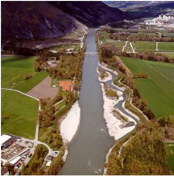
Erosionszustand nach 5 Jahren, April 2001
