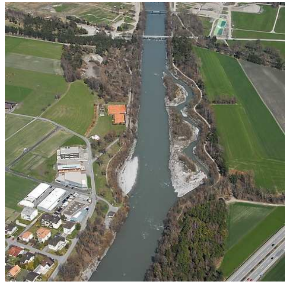
Erosionszustand nach 13 Jahren, April 2009
