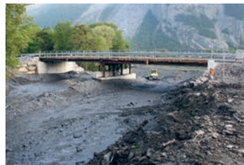
Bova da glietta en la Val Parghera a Domat cun punt provisorica sur la via chantunala, 2013.
