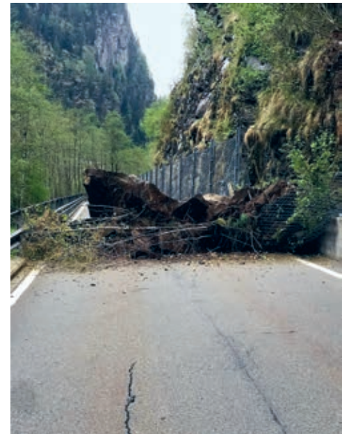
Crudada da blocca sin la via da la Val Calanca, 2020.
