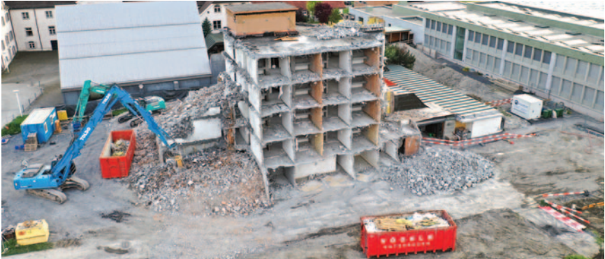
Abbruch altes Internat
