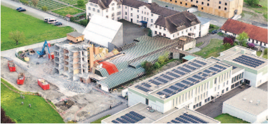
Abriss altes Internat
