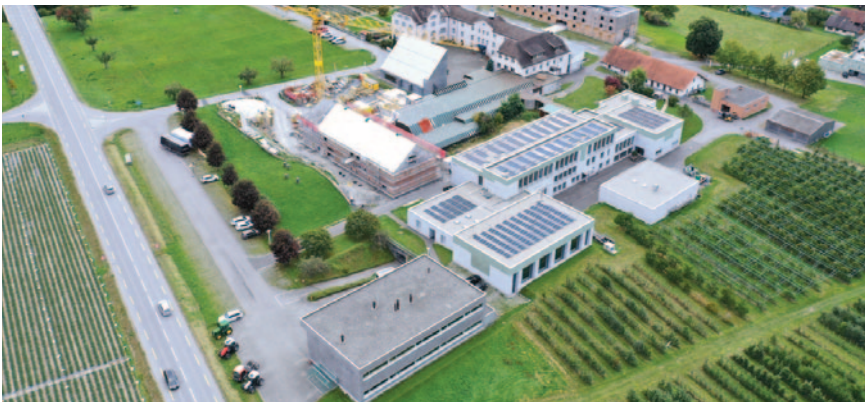
Betriebsgebäude kurz vor der Fertigstellung
