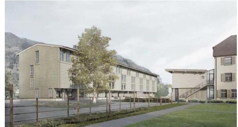
Quelle: Hochbauamt Graubünden
