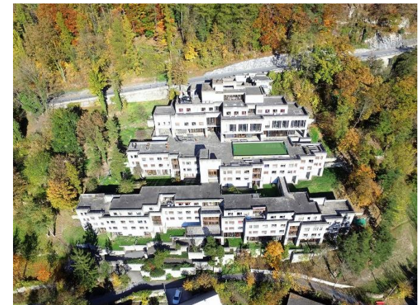
Quelle: Hochbauamt Graubünden
