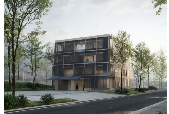
Quelle: Hochbauamt Graubünden / Verkehrsstützpunkt KAPO GR, Chur
