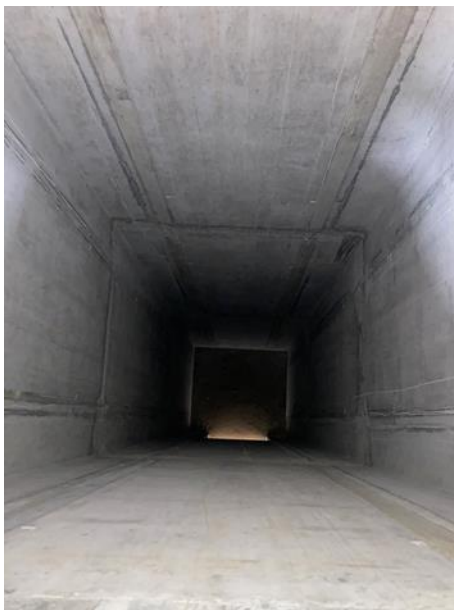
Liftschacht von 3. OG nach unten
