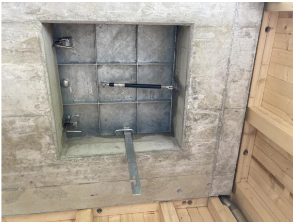
Aufstiegsluke zum Dach
