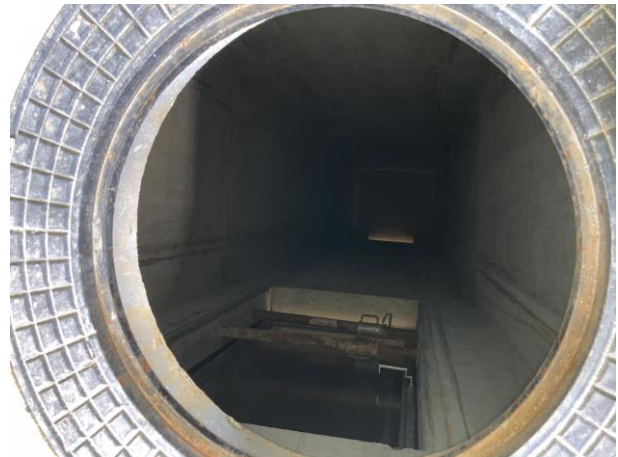
Bodenöffnung Blick durch Lichtschacht
