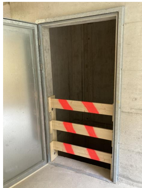
Geländer Bretter als Sicherung
