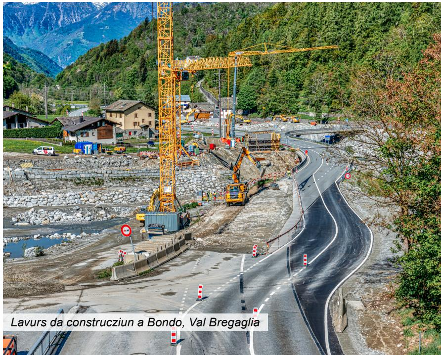
stresas da cuvrida, da basa e da colliaziun allontanadas cun exchavaturs u cun fresas. En stabiliments speziali po silsuenter l'asfalt ch'è resultà cun fresar resp. cun rumper, veginr manizzà a granulat d'asfalt. Quest granulat po veginr reutilisà per producir nov material maschadà.
