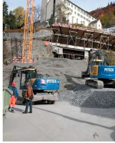
Aufschüttung als Sofortmassnahme
