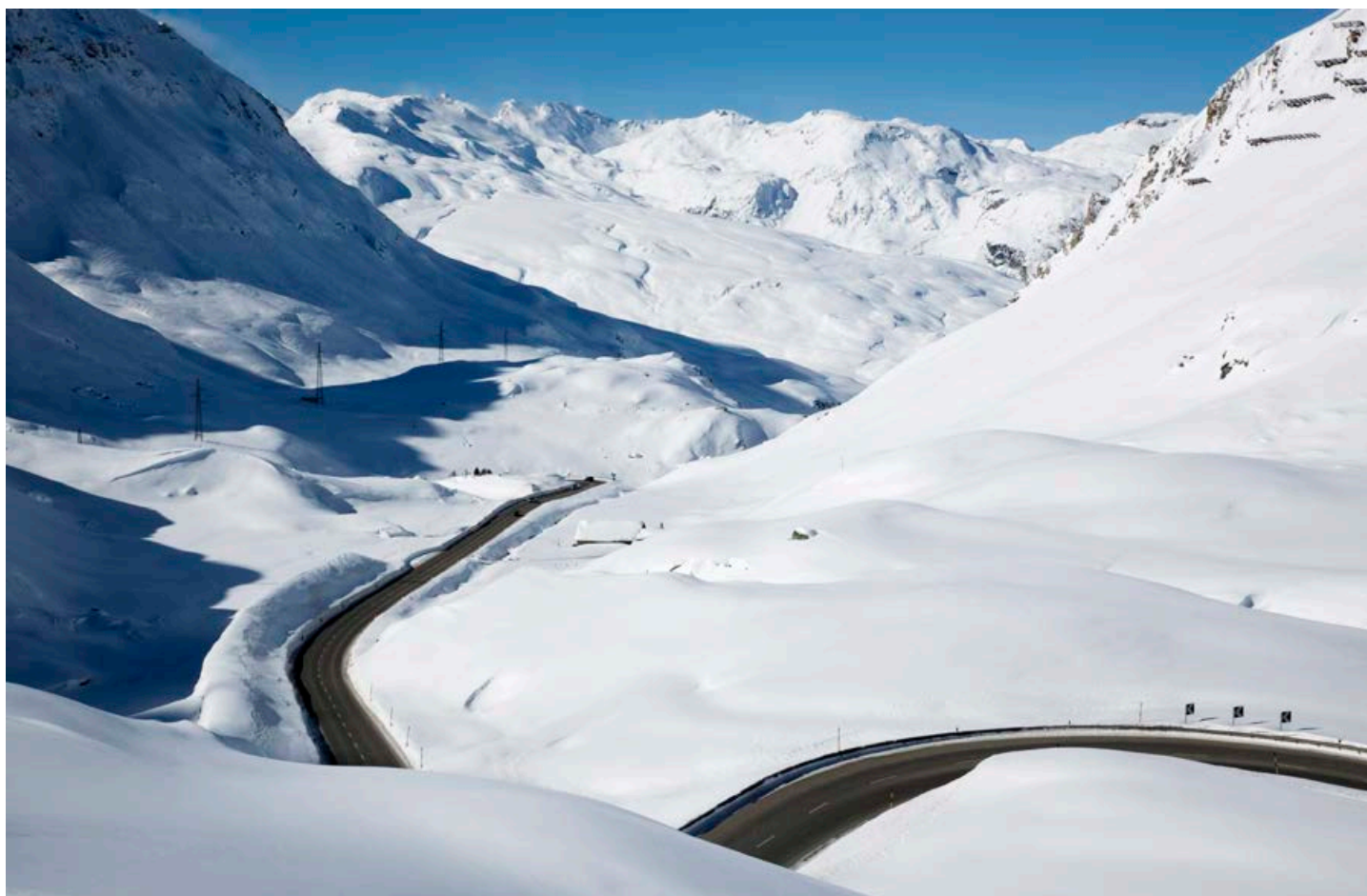
Wintersichere Julierpassstrasse von Bivio nach Silvaplana
