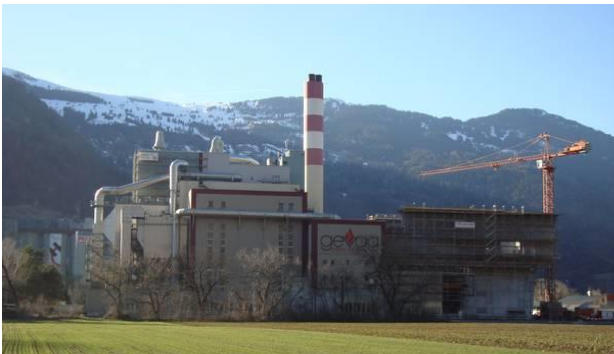
Foto 4: KVA Trimmis, Ausbau 2009/2010 (Quelle: GEVAG)
