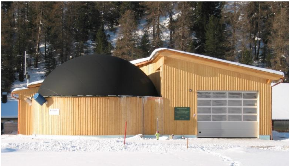
Foto 6: Biogasanlage in Silvaplana (Quelle: Axpo Genesys AG)
