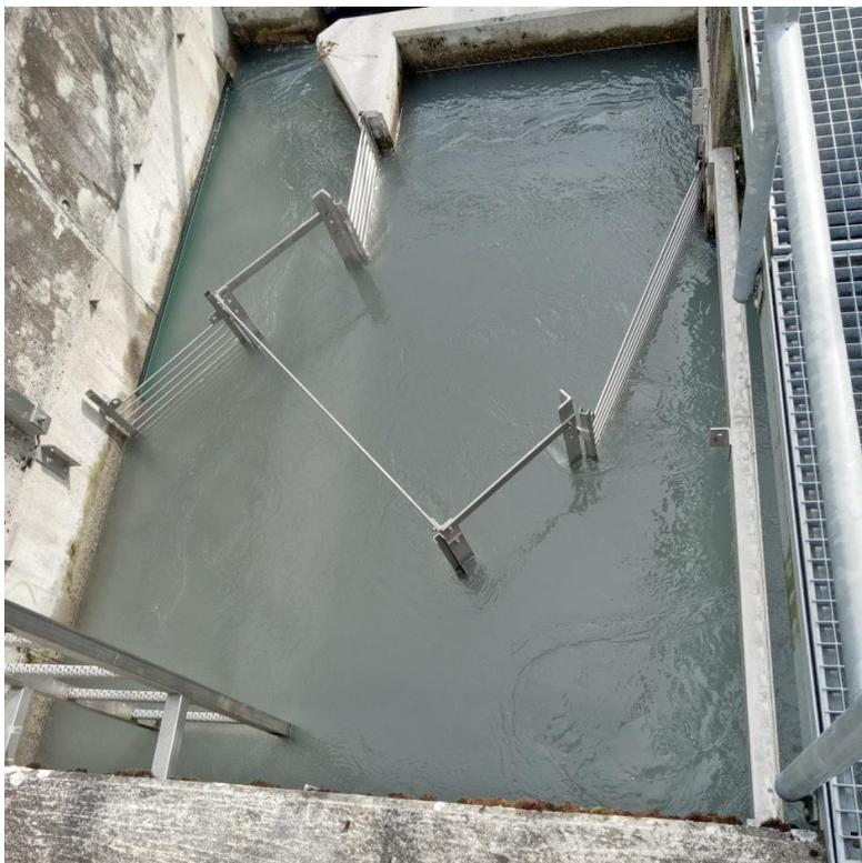
Abb. 3: Leit- und Halterungseinrichtung für das im Jahr 2017 eingebaute und getestete Fischzählsystem "Riverwatcher" im obersten Becken der Fischtreppe des KW Reichenau.
