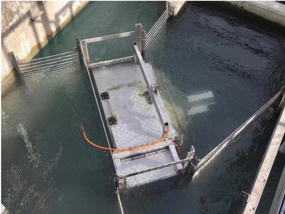
Abb. 1: Installation des Riverwatchers in der FAA am KW Reichenau
