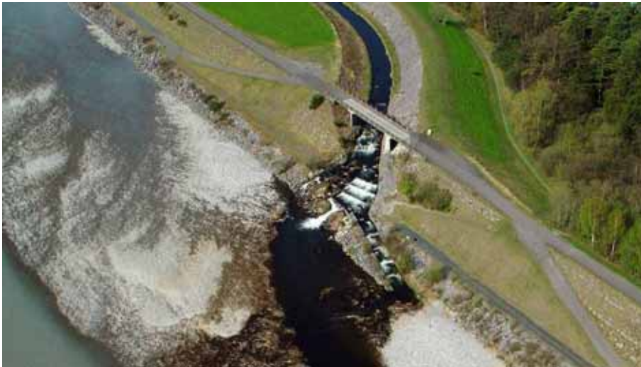
Abb. 3.2.4: Durchgängigkeitsstörung Beispiel Einstiegsstörung
