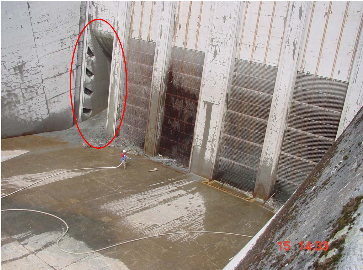
Abb. 3.1 Positionierung eines Bypasses im Nebenauslauf neben den Turbinen (rote Markierung). Mit der Inbetriebnahme eines Bypasses könnte neben der Förderung des Fischabstiegs auch der Ablagerung von Feinsedimenten im Nebenauslass vorgebeugt werden
