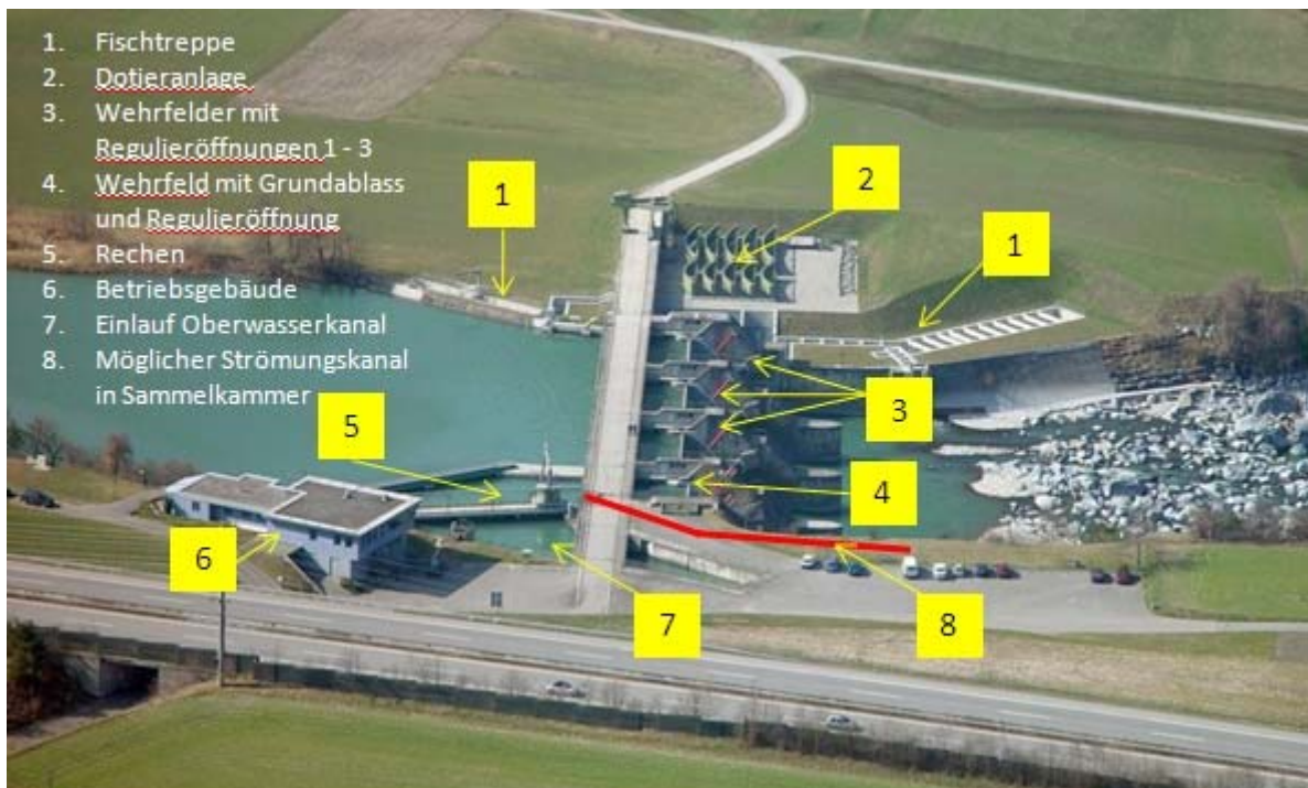
Abb. 4.1 Übersichtplan Wehranlage und Einlauf Oberwasserkanal
