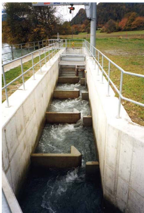
Abb. 9: Oberer Abschnitt Schlitzpass mit Kontrollreuse
