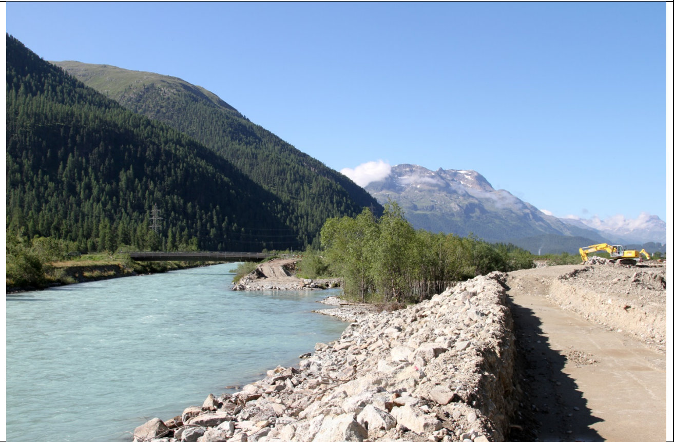
Dammschüttung unterster Bereich
