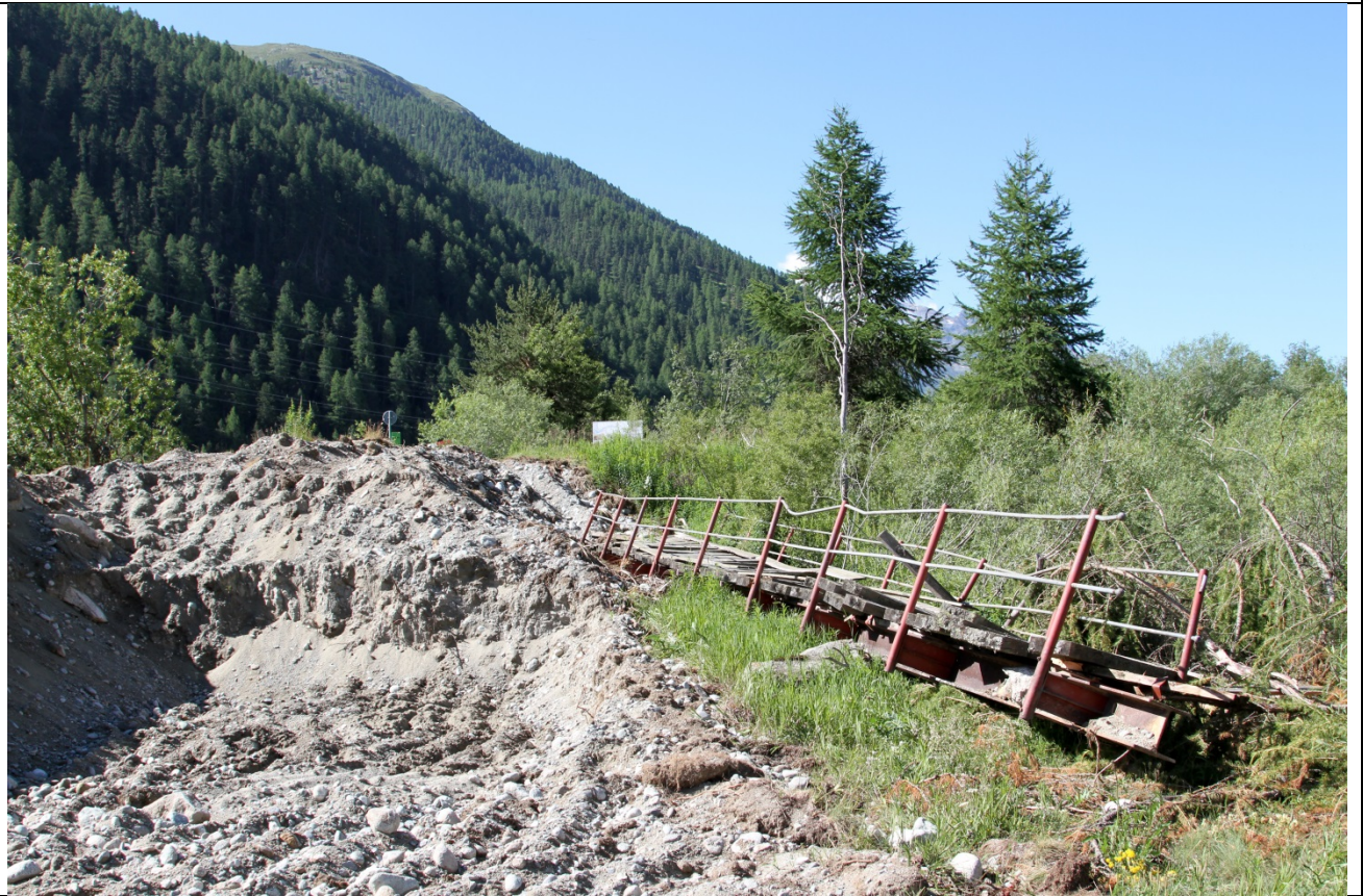
Gerinneaushub Mündungsbereich Beverin
