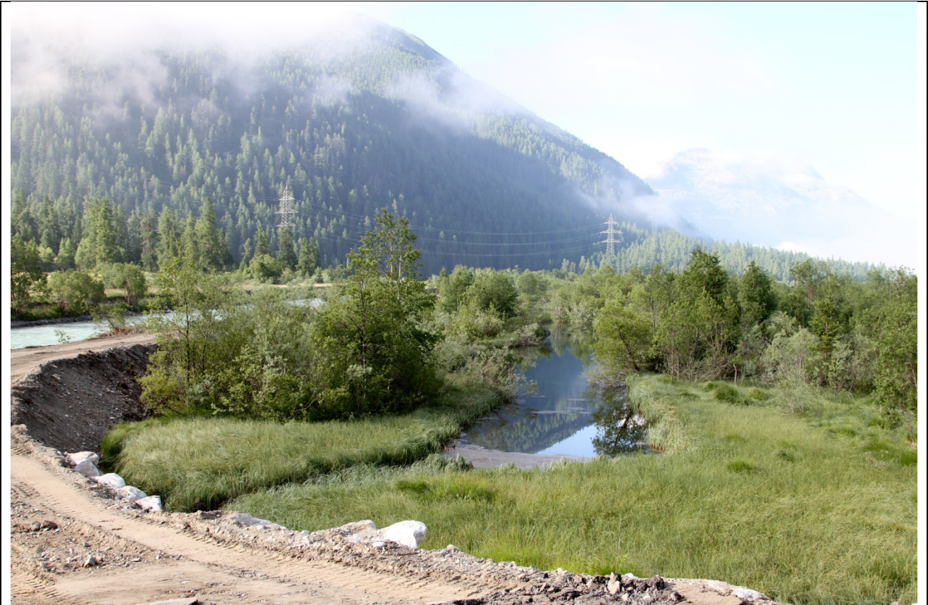
Bauphase unterhalb Kantonsstrasse
