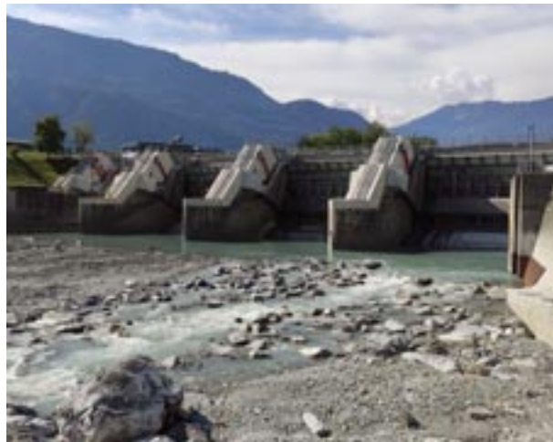
Situation beim Kraftwerk Reichenau September 2022
