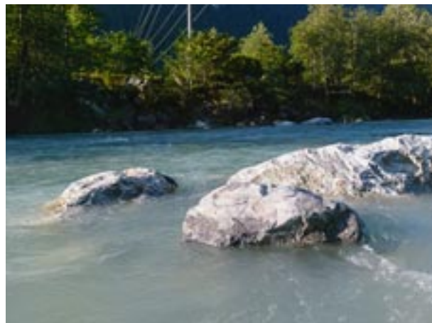
Durch Störsteine werden in einem ursprünglich monoton fliessenden Flussabschnitt mehr Strömungsvariabilitäten geschaffen. Der gewünschte Effekt von unterschiedlichen Fliesstiefen und Strömungsverhältnissen konnte bereits 2 Monate nach Einbau beobachtet werden.
