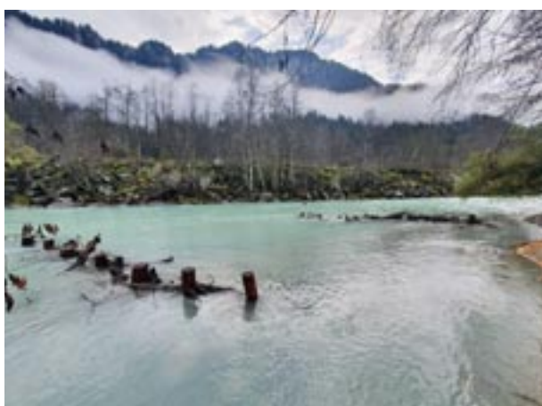
Zur Erhöhung der Strömungsvariabilität werden Strömungstrichter erstellt. So soll eine Kolkbildung und damit gute Fischeinstände, insbesondere für Adultfische entstehen. Die Elemente werden dabei über- und umflossen.
