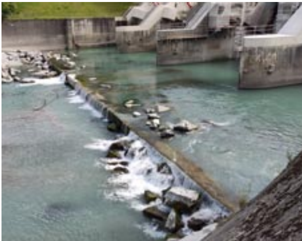
Situation beim Kraftwerk Reichenau September 2021
