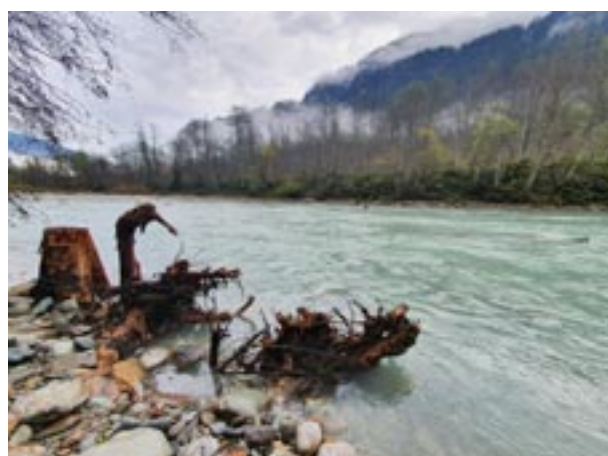
Eingebrachte Wurzelstöcke, in Ufer eingegraben und gesichert. Dadurch soll die Strukturvielfalt im Uferbereich erhöht und damit wichtige Jungfischhabitate geschaffen werden.
