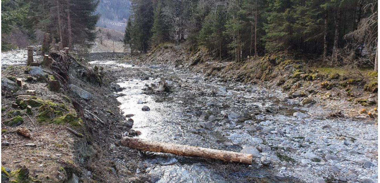
Allargamento del letto del fiume con strutture di legno morto lungo il Poschiavino
