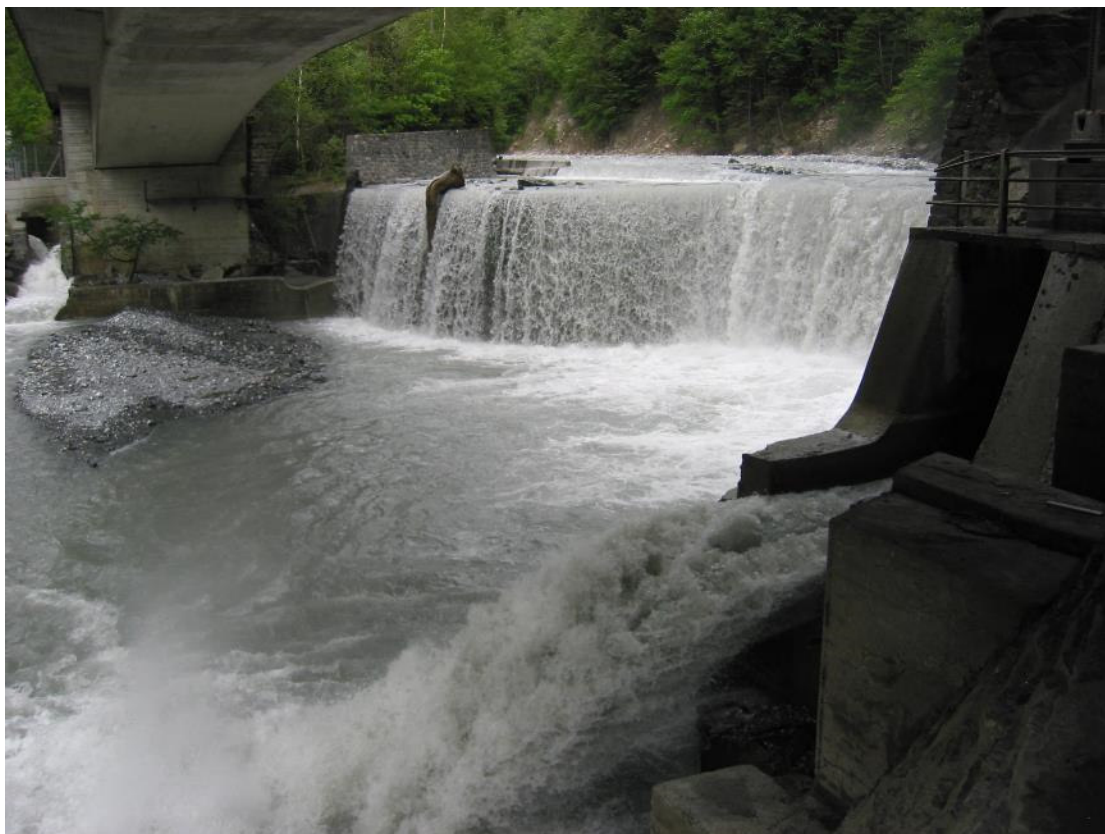
Chlusfall im Unterlauf der Landquart: Seit 120 Jahren bestehendes Wanderhindernis für Fische
