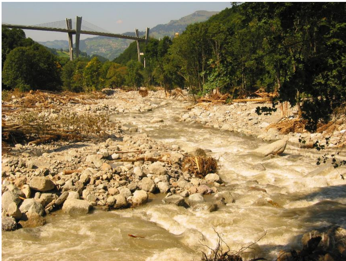
Landquart bei Serneus nach Hochwasser 2005
