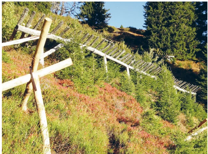
Eine langfristige Planung der jährlichen Eingriffe im Schutzwald hilft selbst im Fall ausserordentlicher Ereignisse, die Ziele effizient zu verfolgen. Temporäre Schutzbauten können als Überbrückung dienen.
