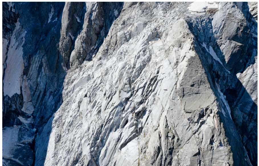
Abb. 7. Aufnahme der instabilen Felsmasse vom 11. August 2016. Der linke, stark frakturierte, helle Bereich ist am 23. August 2017 abgestürzt. Der Pfeiler im rechten Teil des Bilds ist weitgehend stehen geblieben (Foto: Y. Bonanomi).
