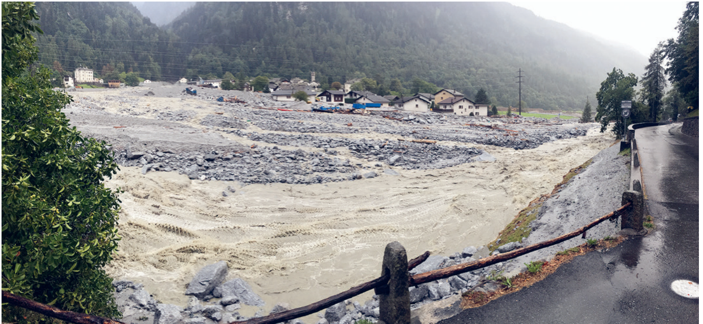
Abb. 15. Situation am 1. September 2017 nach dem letzten grossen Murgang vom 31.08.2017. Zu diesem Zeitpunkt lagen im und rund um das Becken von Bondo 490000 m 3 Murgangmaterial (Foto: AWN).
