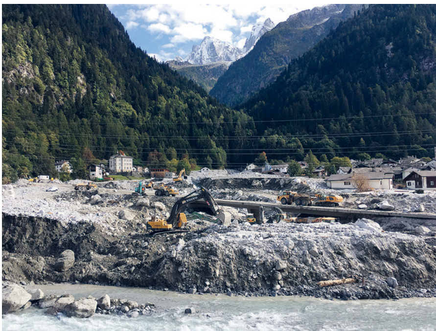
Abb. 17. Grossbetrieb im Hauptablagerungsgebiet Bondo–Auffangbecken. Dort war eine ständige Koordination durch Bodenpersonal vor Ort essenziell, um Unfälle zu vermeiden und eine bestmögliche Effizienz zu gewährleisten (Foto: AWN).
