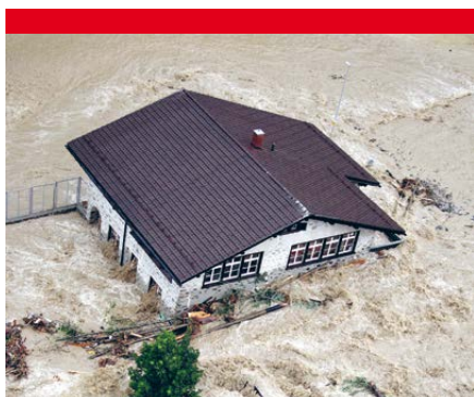
Erhebliche Gefährdung durch Wasser (Gefahrenstufe rot): Ereignis 2005, Klosters (Foto: Foto Schmelz, Klosters)
