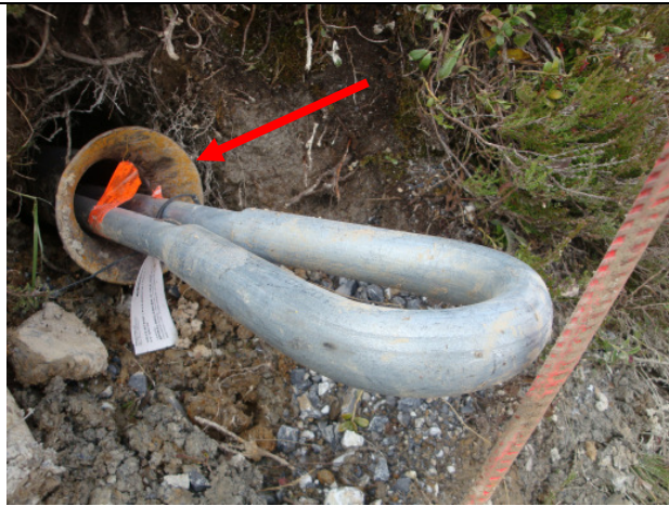
Abb.4. Stabilitätsrohr mit Trompete
