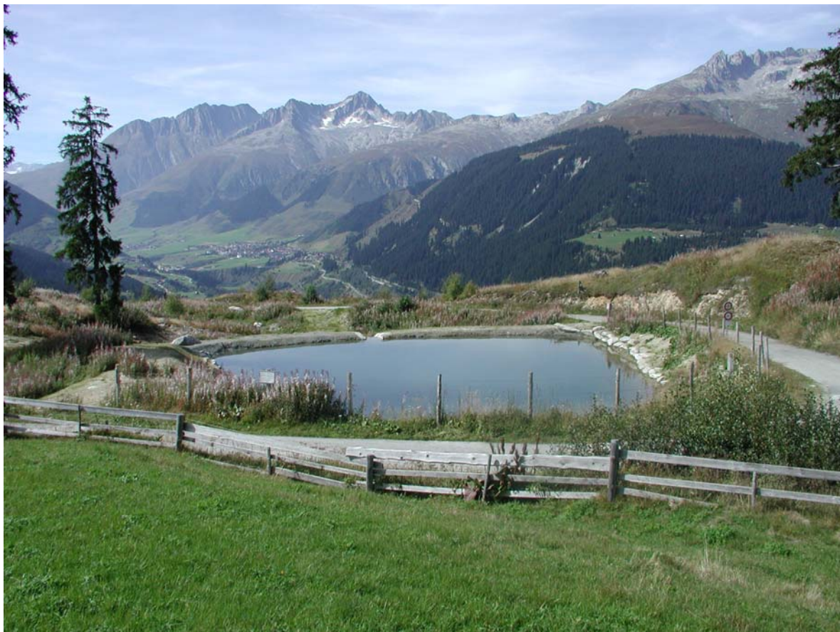
Abb. 9: Künstlich angelegter Löschwasserteich in Stagias, Gemeinde Disentis/ Mustér.
