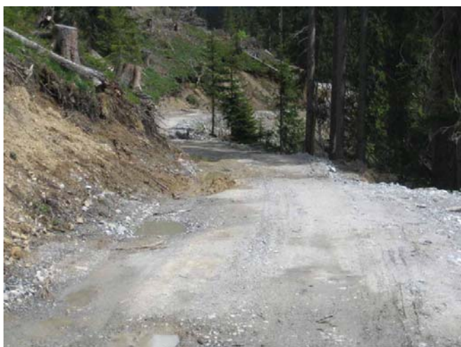
Abb. 5: Temporäre Walderschliessung im Sunniwald, Gemeinde Schiers (Quelle: Mario Gross, Forst & Transporte).
