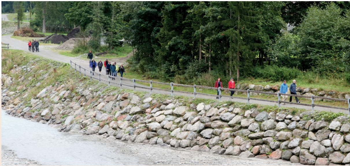
Während eines kleinen Spazierganges konnten sich die Berner und Bündner Regierungen austauschen. (Foto AWN)
