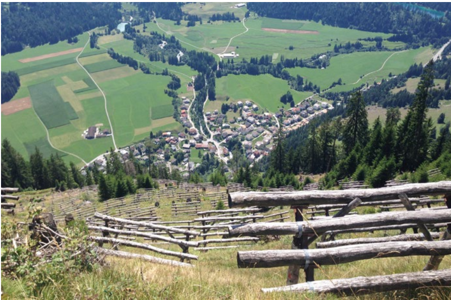
Im Schutz der temporären Lawinerverbauungen wächst der junge Schutzwald. (Foto AWN)
