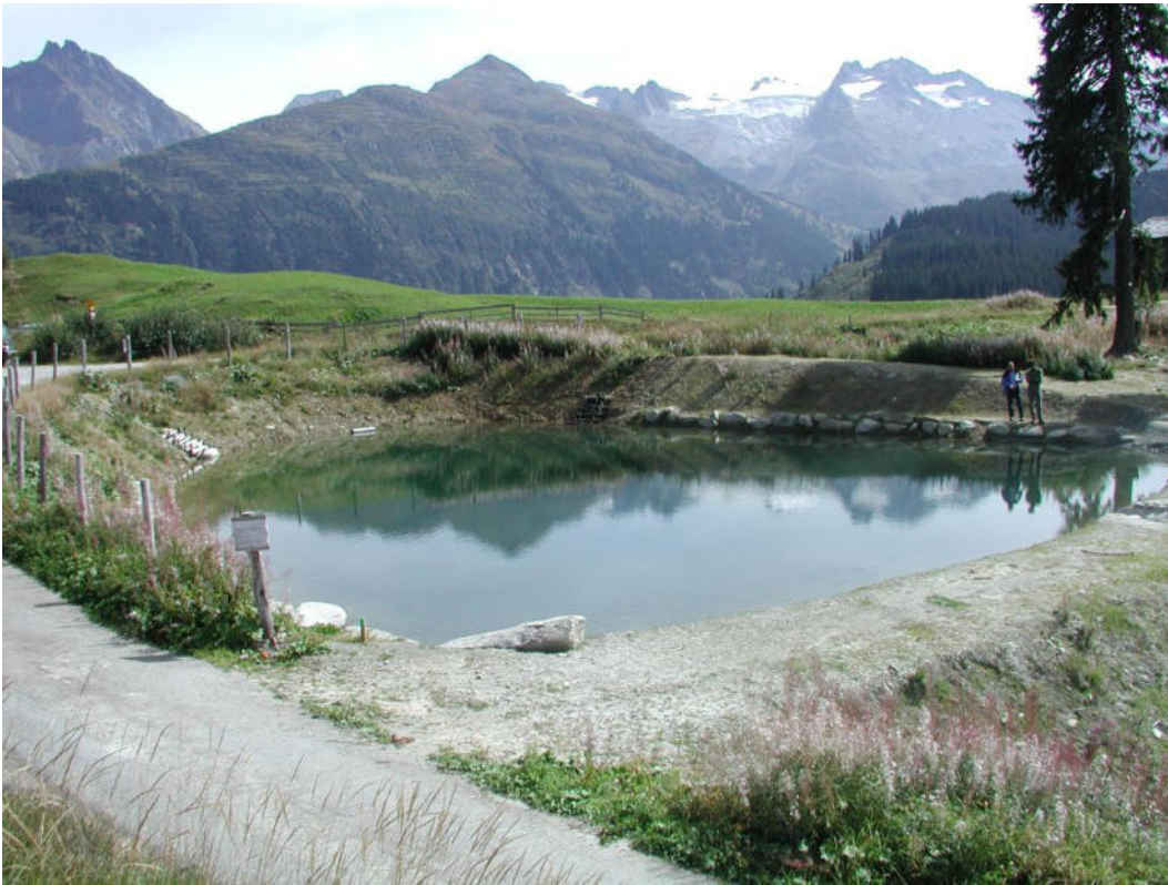
Abbildung 5: Der Löschwasserteich Stagias in der Gemeinde Medel Lucmagn wurde im Jahr 2001 als Wasserreserve für die Brandbekämpfung und zum Schutz der umfangreichen Vivian-Wiederaufforstungsflächen erbaut.
