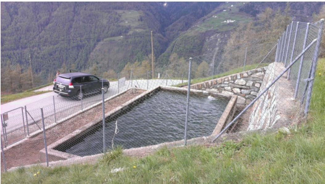
Abbildung 6: Wasserentnahmestelle aus Beton am Standort Val Irola oberhalb von Viano – Gemeinde Brusio.
