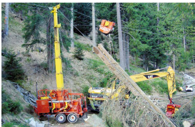
Holzernte mit Seilkrananlage und Prozessor an der Waldstrasse
