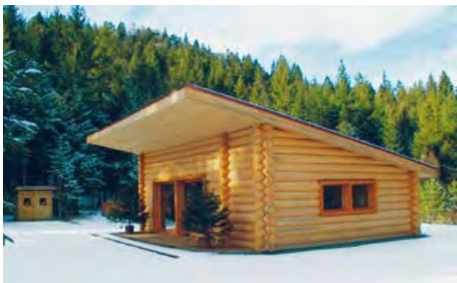
Tannenholz kann genauso gut im Holzbau verwendet werden wie Fichtenholz. Seine Verwendung bringt keine Nachteile für das Bauwerk. Im Bild oben das Blockhaus Bonaduz. (Heiri Mannhart)
