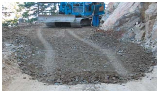
Einbau von Tragschicht und Deckbelag: Je nach Beanspruchung des Waldweges werden natürliche Beläge wie Sand-Kies oder aufbereitete Materialien wie Beton oder Asphalt verwendet.
