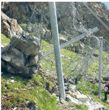
*Durch Steinschlag beschädigtes Schneenet*
