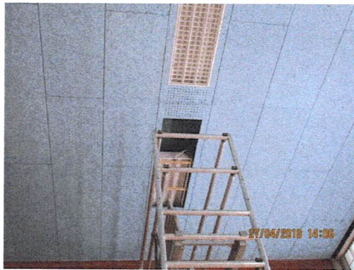
a) Abgehängte Akustikdecke und Beleuchtung
