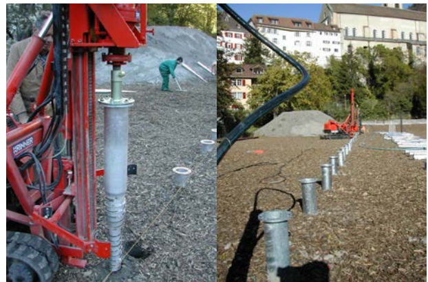
Die Holzbauten stehen auf insgesamt 400 Schraubfundamenten aus verzinktem Stahl 1.60 bis 2.00 m lang
