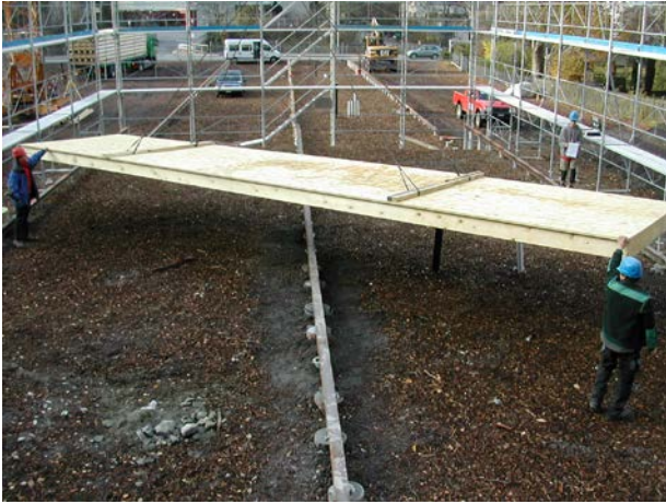
Am 13. November 2006 (1 Monat nach erteilter Baubewilligung) war Montagebeginn des ersten Holzpavillons.
