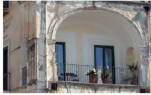
Loggia und Balcone
