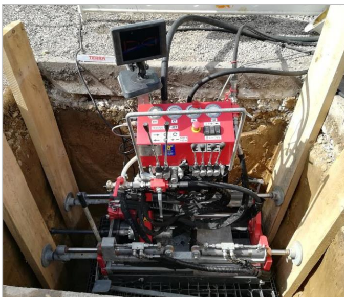
Grubenbohranlage: Baugrube 1.5 x 1.5 Meter
