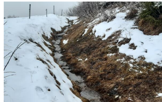
Abbildung 20: Beispiel eines hangquerenden Grabens in Runchiola, welcher instand gestellt wird (Strang H1).
