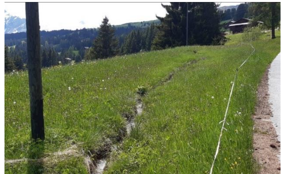
Abbildung 16: Beispielbild Entwässerungsgraben, Sarn
