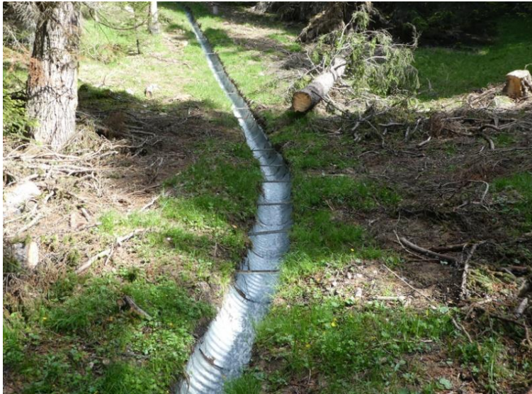
Abbildung 21: Wellstahlhalbschalen zum Ableiten von Wasser. Beispiel Brienzer Maiensässe
