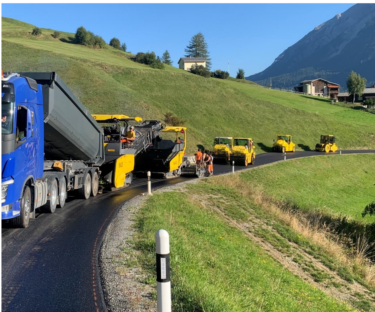
720.17 Cunterstrasse, Mon – Navaras, km 4.40 – 5.87
