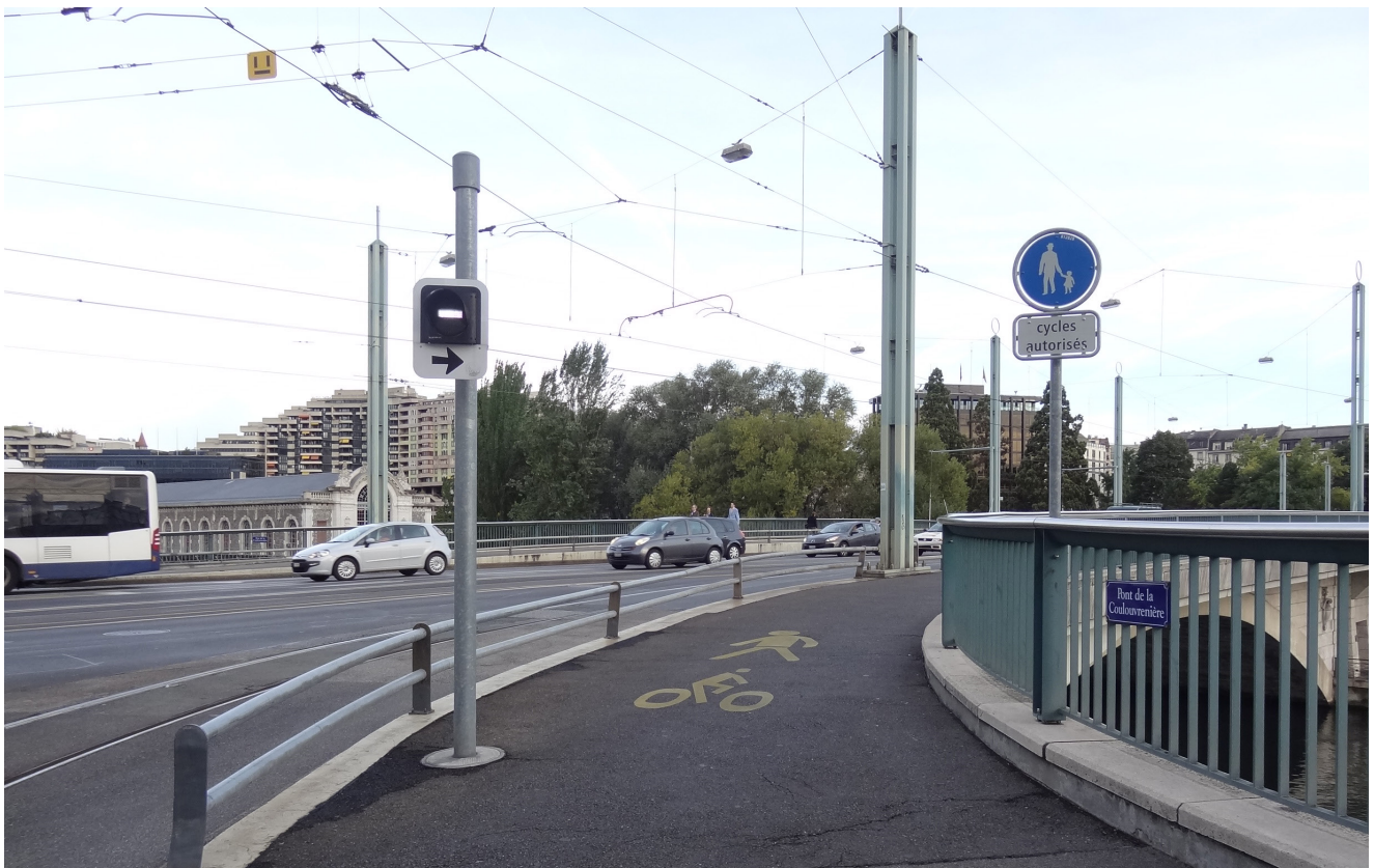
Bild 6: Beispiel eines von Velo- und Fussverkehr gemeinsam genutzten Bereichs beim Pont de la Coulouvrenière in Genf. Obwohl die Benutzung in diesem Fall für Fahrräder nicht obligatorisch ist und die schnellen E-Velos ihren Motor abschalten müssen, spricht der E-Velo-Boom dafür, dass gemeinsame Anlagen mit mehr Vorsicht geplant werden.
