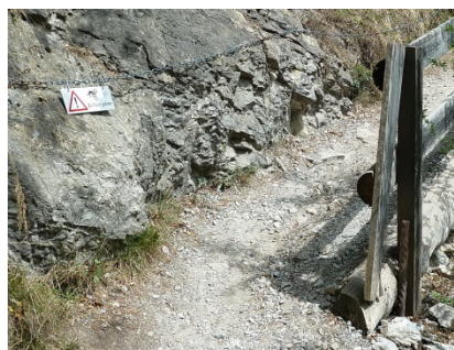
Haltevorrichtung mit Hinweis zur Absturzgefahr und Aufforderung, zu Fuss zu gehen.
