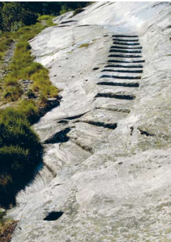
Fels: Künstliche Trittstufen erleichtern die Begehung eines vom Gletscher geschliffenen Granitfelsens. «Hälenplatte» am Grimsel-Saumpfad, Guttannen BE (ViaStoria/Guy Schneider).
