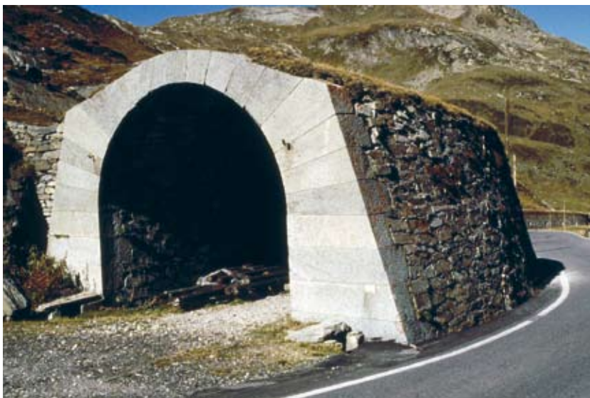
Lawinengalerie auf der Nordseite des Splügenpasses GR. Der Passübergang wurde in den 1840er-Jahren mit solchen Galerien wintersicher ausgebaut (ViaStoria/Arne Hegland).
