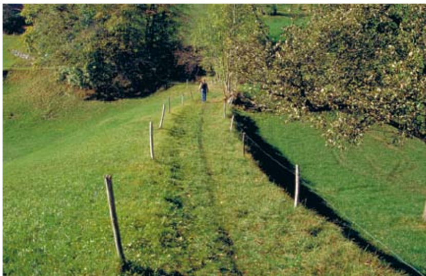
Die «Chüegass» am Grabserberg SG hat durch die Aufschüttung eines Erd-damms ein gleichmässiges Gefälle erhalten (ViaStoria/Andriu Maissen).
