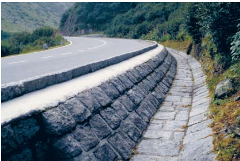
Mit vermörtelten Steinquadern ausgekleideter Strassengraben. Die streng geometrische Form wird der historischen Strasse nicht gerecht. Gotthardstrasse UR (ViaStoria/Arne Hegland).
