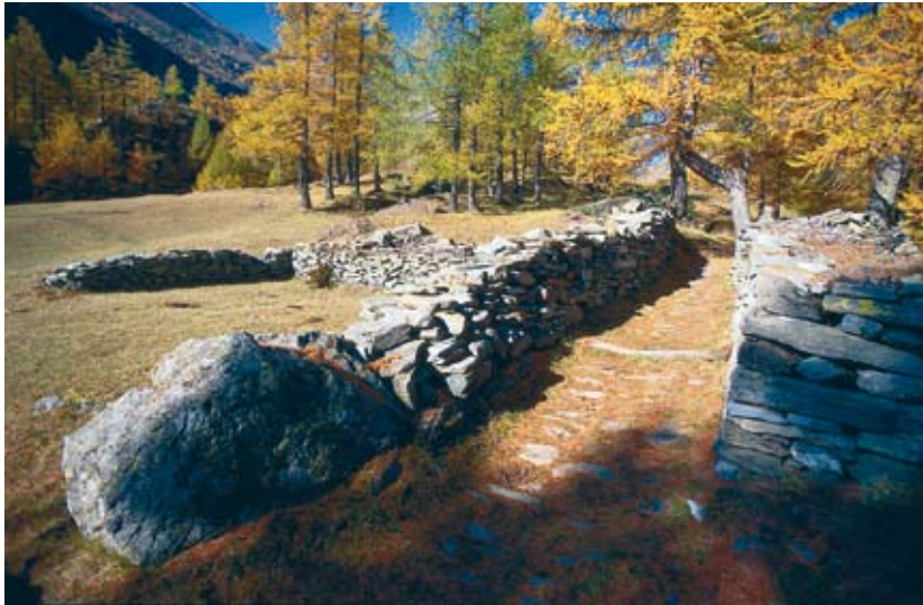
Der als Saumweg im 17. Jahrhundert gebaute Stockalperweg in Engi südlich des Simplonpasses VS. Die Breite und die Beschaffenheit des Weges entsprechen dem damals üblichen Transport von Waren auf Saumtieren und den technischen Möglichkeiten im Wegbau (ViaStoria/Heinz Dieter Finck).
