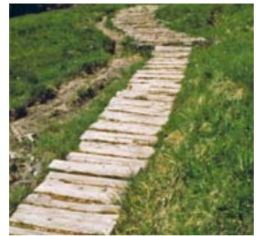
Der «Alte Schwyzerweg» über die Ibergergg SZ durchquert als Bohlenweg ein Feuchtgebiet (ViaStoria/Arne Hegland). Vgl. auch Abb. S. 36.
