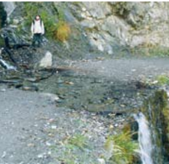
Eine gemauerte Strassenfurt in alpinem Gelände mit hoher talseitiger Stützmauer an der alten Erschliessungsstrasse des Binnntals VS (ViaStoria/Guy Schneider).
