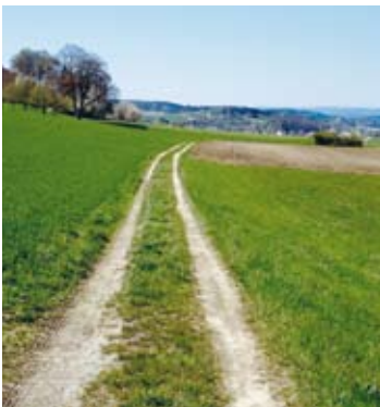
Güterweg zwischen Ramsen SH und dem deutschen Murbach. Trotz der leichten Hangneigung sind keine Wegbegrenzungen sichtbar (ViaStoria/Andriu Maissen).
