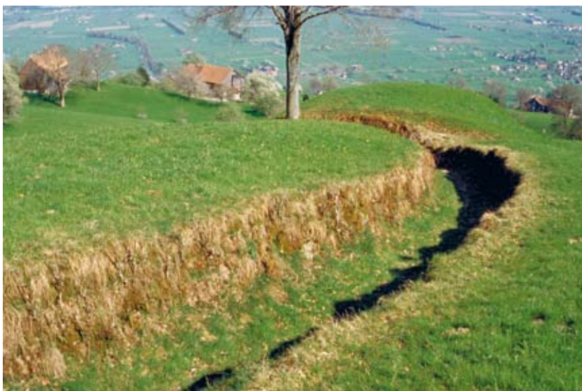
Diese Gasse oberhalb von Gams SG ist vollständig in den Boden eingelassen und mit Trockenmauern eingefasst, wodurch ein Ausreissen des Viehs in die angrenzenden Wiesen verhindert wird (ViaStoria/Andriu Maissen).
