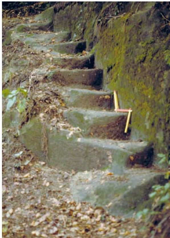
Fels: Ausgehauene Treppenstufen eines Fusswegs im Molasse-Sandstein. Schwarzwassergraben BE/FR (ViaStoria/Fredi Bieri).
