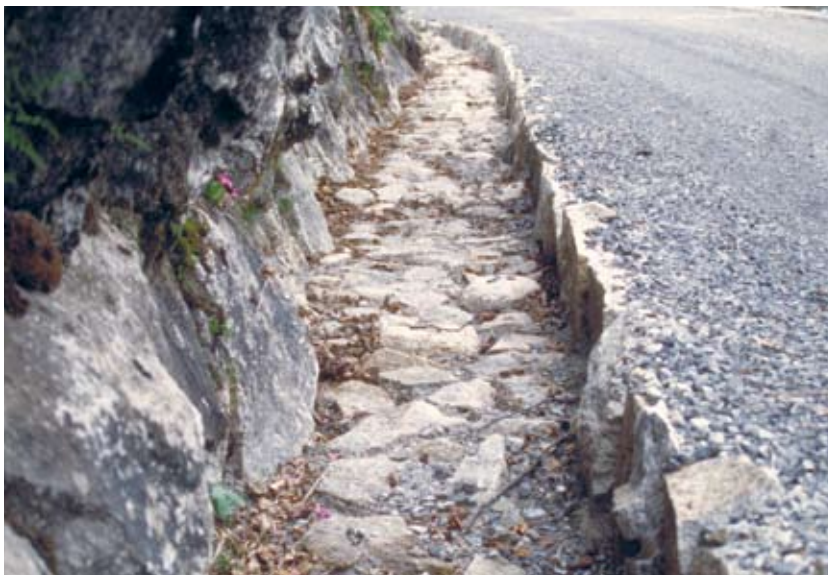
Handwerklich ausgeführter Strassengraben aus Bruchsteinen mit Steinbett. Alte Gotthardstrasse in der Schöllenen UR (ViaStoria/Arne Hegland).
