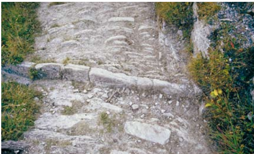
Querabschlag aus hochgestellten Steinplatten am nicht befahrbaren Alpweg von Bargis GR auf den Flimserstein (ViaStoria/ Arne Hegland).
