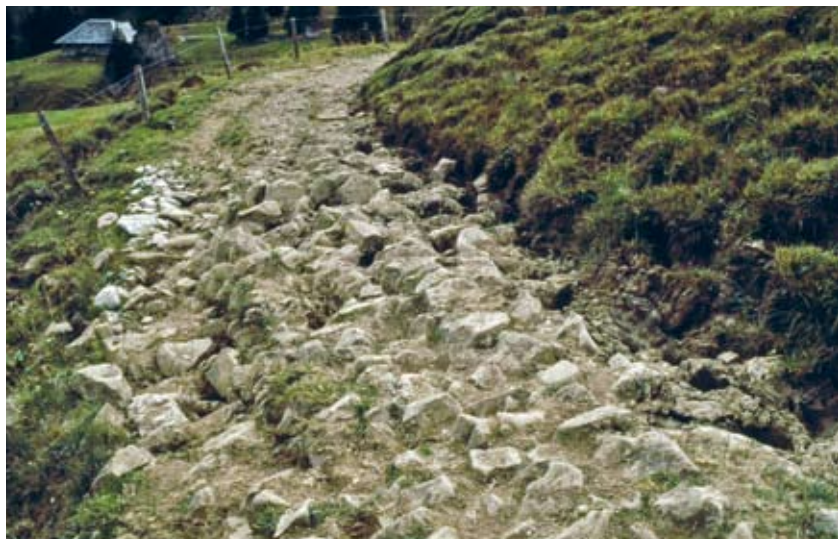
Das grobe Steinbett dieses geschotterten Fahrwegs trägt die Wegdecke in einer Feuchtstelle. Nünalp, Giswil OW (ViaStoria/ Arne Hegland).
