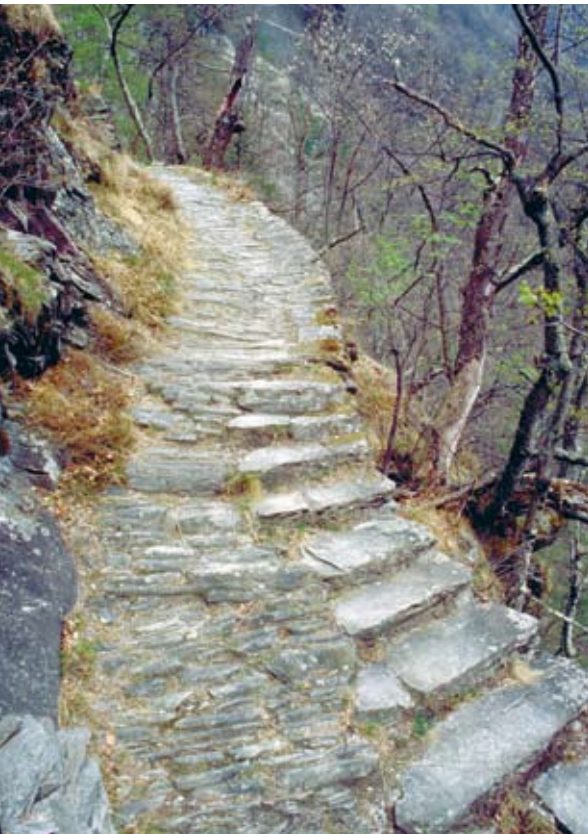
Aufwändig gebauter Saumweg in einer Steilstufe: Er besitzt ein Reihensplaster mit hochkant gestellten Platten und Trittstufen aus Steinplatten. Zwischen Promontogno und Soglio GR (ViaStoria/Guy Schneider).
