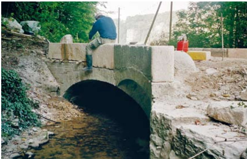
Restaurierung: Die Brücke über den Homburgerbach bei Läuelfingen BL, eine Strassenbrücke von 1810, wurde 2002 restauriert, wobei die Quader der Brüstungsmauern neu versetzt und einzelne Steine ausgewechselt wurden. Sie gehört heute zu einer Güterstrasse, die auch als Radweg signalisiert ist (ViaStoria/Eneas Domeniconi).
