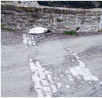
Gepflästerte Entwässerungsschale einer alpinen Kunststrasse, die direkt über ein ausgespartes Bogenfenster der Brüstungsmauer entwässert. Die Wanne ist periodisch vom Kies der Strassenoberfläche zu befreien (ViaStoria/Arne Hegland).
