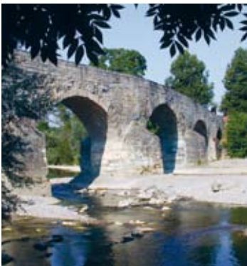
Instandsetzung und eingeschränkte Weiterverwendung: Die spätmittelalterliche Thurbrücke von Bischofszell TG wurde 2000–2005 mit Mauerwerksicherung, Abdichtung und Entwässerung sowie fussgängerfreundlichem Fahrbahnelag belag renoviert (Andres Betschart).
