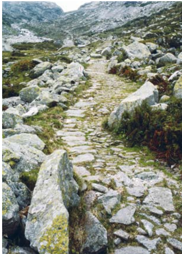
Der Gotthard-Saumfad auf dem Mätteli zwischen Hospental UR und der Passhöhe. Nach der Freilegung ist die Struktur der Pflasterung beispielhaft sichtbar geworden (ViaStoria/Heinz Dieter Finck).
