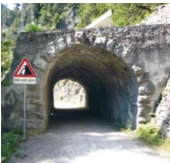
Diese historische Schutzgalerie konnte erhalten werden, weil die Kantonsstrasse in einen Tunnel verlegt wurde. Aus diesem Grund muss die Galerie modernen Anforderungen in Bezug auf das Lichtraumprofil nicht genügen. Alte Zügenstrasse Davos–Wiesen GR (ViaStoria/Arne Hegland).
