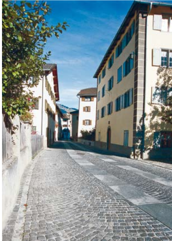
Innerörtliche Kleinsteinpflasterung («Bsetzi») im Bogenmuster. Durch die beiden Fahrspuren aus Plattenreihen nach dem historischen Vorbild der Postkutschenstrassen lässt sich der Fahrkomfort verbessern und die Lärmbelastung reduzieren. Andeer GR (ViaStoria/Heinz Dieter Finck).
