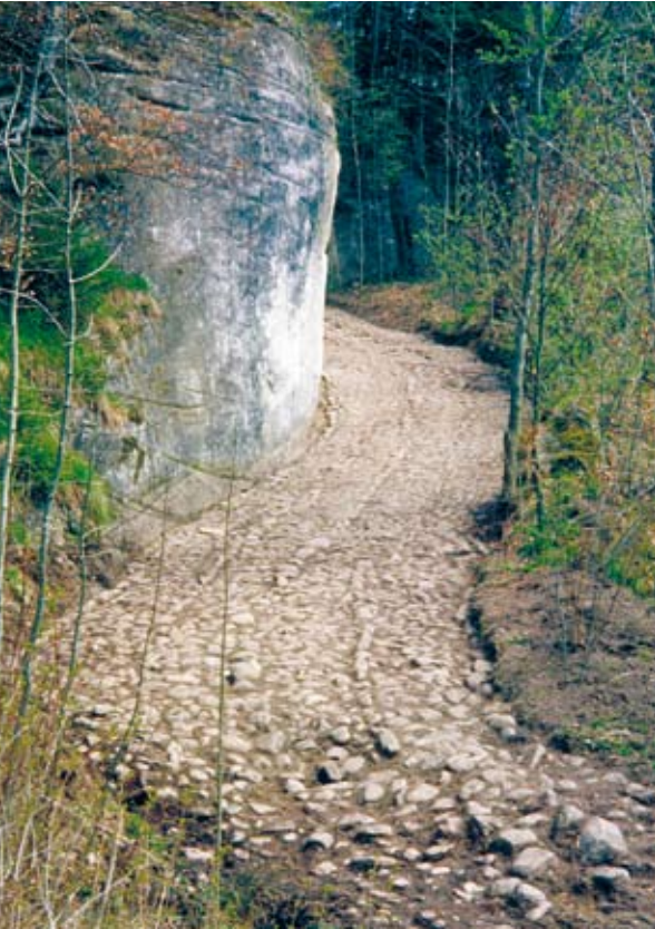
Diese Katzenkopfpflasterung aus Flusskieseln bildet eine durch Steinreihen unterteilte Fahrbahn. An der Sense bei Heitenried FR (ViaStoria/Fredi Bieri).
