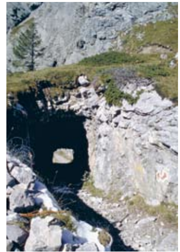
Der Ausbruch dieses einfachen, nicht ausgekleideten Tunnels in kristallinem Fels geht auf eine Erneuerung des Rawil-Saumpfades auf der Walliser Seite im 19. Jahrhundert zurück (ViaStoria/Vanessa Bitz).
