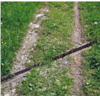
Querabschlag aus Metall. Obwohl für traditionelle Wege materialfremd, kann ein dosierter Einsatz solcher eher diskret wirkender Querabschläge auch bei historischen Wegen ins Auge gefasst werden (ViaStoria/Guy Schneider).
