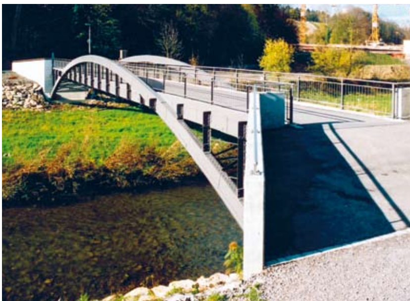
Versetzung: Die Höcklerbrücke von 1866 über die Sihl in Zürich-Leimbach ZH wurde 1998/99 aus ihren alten Widerlagern gehoben, an Land instand gestellt und flussaufwärts auf neue Widerlager gesetzt. Dabei wurde sie auf ihr Tragwerk, einen nicht selbsttragenden, eingespannten Bogen, reduziert und mit neuen Widerlagern und einer neuen Fahrbahnplatte ausgestattet. Sie ist heute Teil des Langsamverkehrsnetzes (Basler & Hofmann/Michael Ruf).
