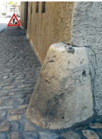
Bearbeiteter, in die Mauerecke eingebauter Radabweiser aus Jurakalk an einer Hausecke in Thun BE (ViaStoria/ Guy Schneider).
