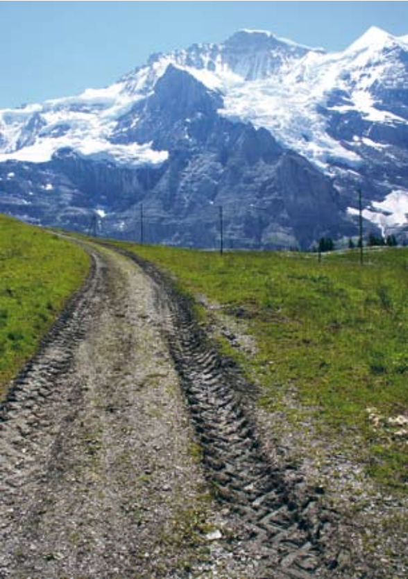
Lockermaterial: Ein Bewirtschaftungsweg mit erdig-sandiger Oberfläche. Wengernalp BE (ViaStoria/Guy Schneider). Vgl. S. 51.
