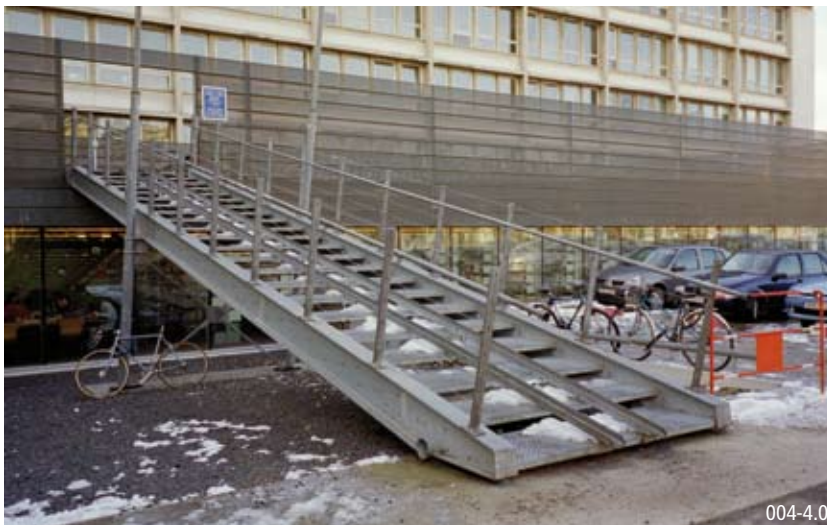
Treppe mit Schieberinnen
