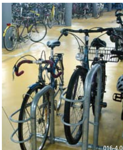
Vorderradhalter (nur in abschliessbaren Anlagen)
