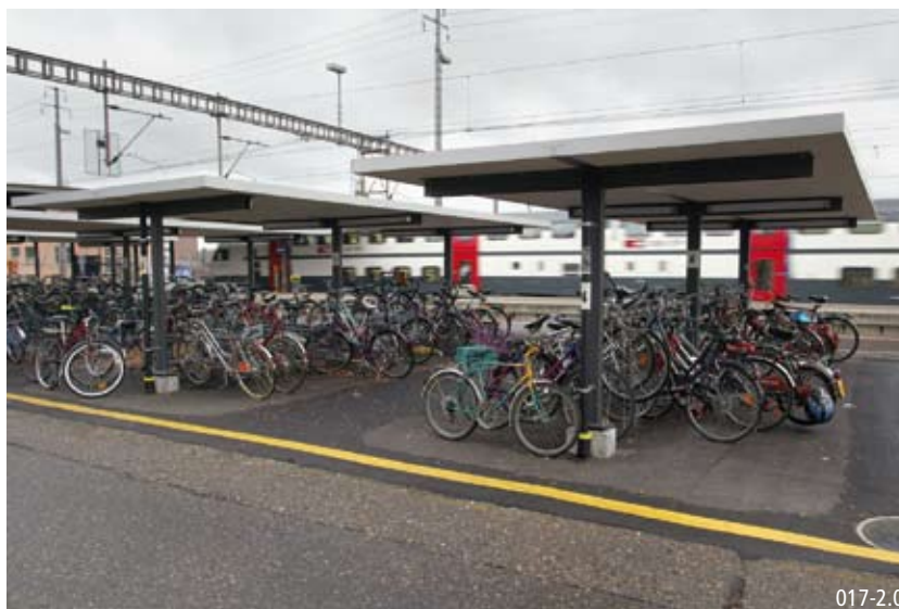
Nahe am Perron, gedeckt und beleuchtet
