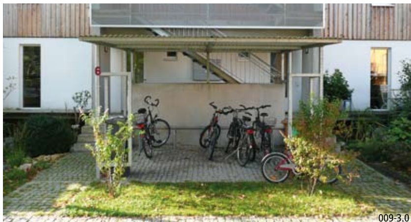
Bei Gesamt-sanierung der Siedlung integrierte Veloparkierung
