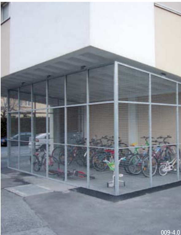
Abschliessbare Anlage mit eingeschränktem Benutzerkreis
