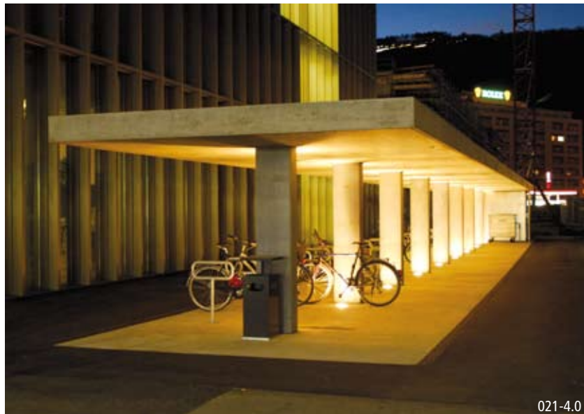
Gut beleuchtete Anlage in massiver Bauweise
