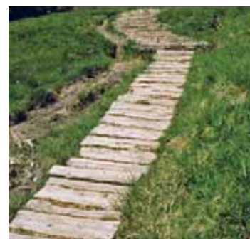
La «Alter Schwyzerweg» sopra l'Ibergeregg SZ è un camminamento a tavoloni che attraversa una zona umida (ViaStoria/Arne Hegland). Cfr. fig. p. 36.
