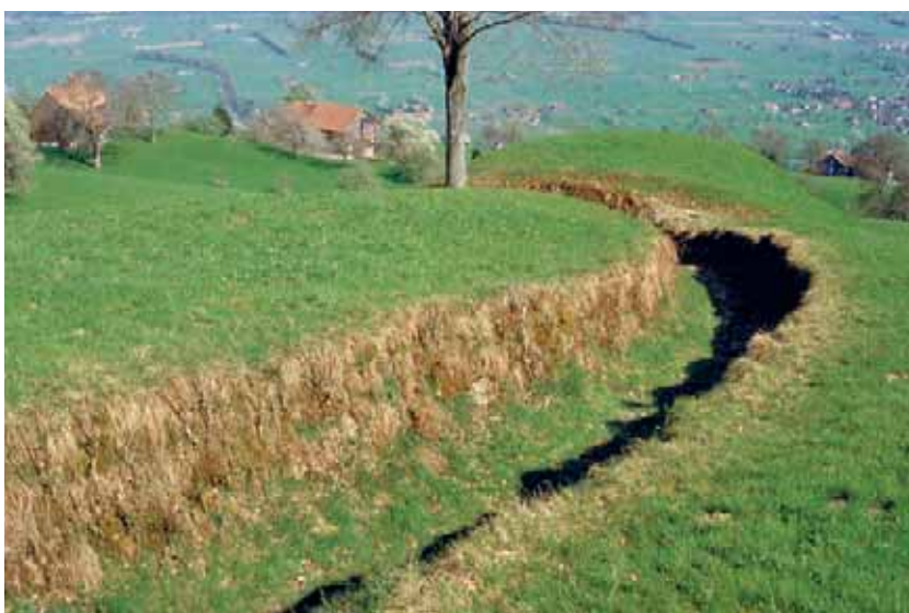
Questa strada di campagna sopra Gams SG, è integralmente incavata nel terreno e fiancheggiata da muri a secco per impedire al bestiame di invadere i prati adiacenti (ViaStoria/Andriu Maissen).
