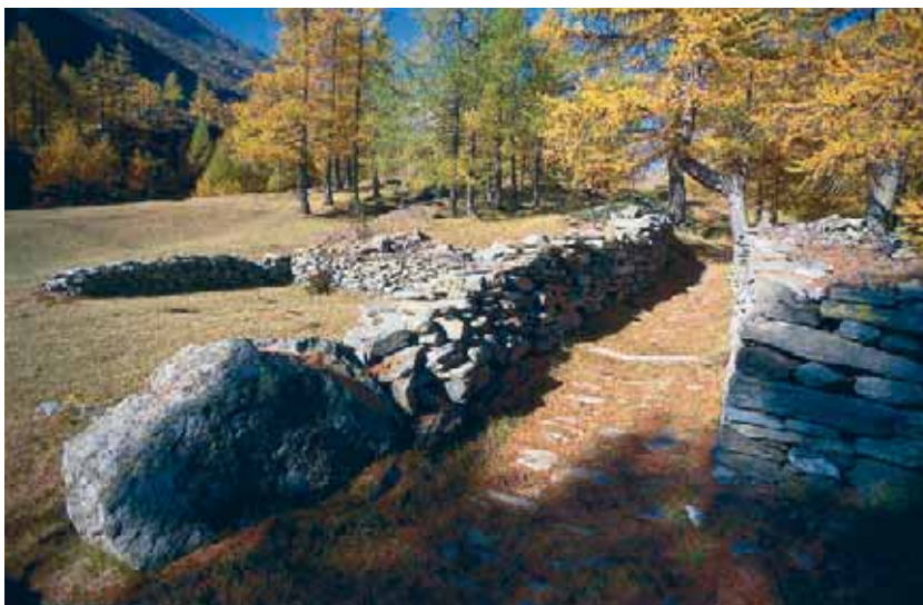
La Via Stockalper a Engi, sul versante meridionale del Passo del Sempione VS, è una mulattiera costruita nel XVII secolo. La larghezza e la natura della via si adattano al trasporto di merci con bestie da soma, comune a quel tempo, e alle possibilità tecniche e costruttive dell'epoca (ViaStoria/Heinz Dieter Finck).
