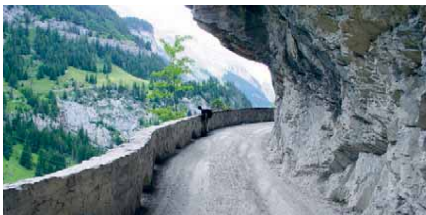
Questa semigalleria ricopre la strada per quasi tutta la sua larghezza. Gasterenstrasse, Kandersteg BE (ViaStoria/Guy Schneider).
