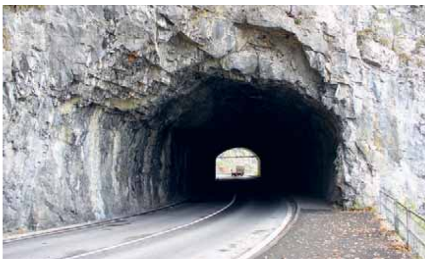
Tunnel del 1884 scavato nella compatta roccia calcarea, non modificato ma provvisto in tempi successivi di marciapiede. Strada del Beatenbucht sul lago di Thun BE (ViaStoria / Guy Schneider).
