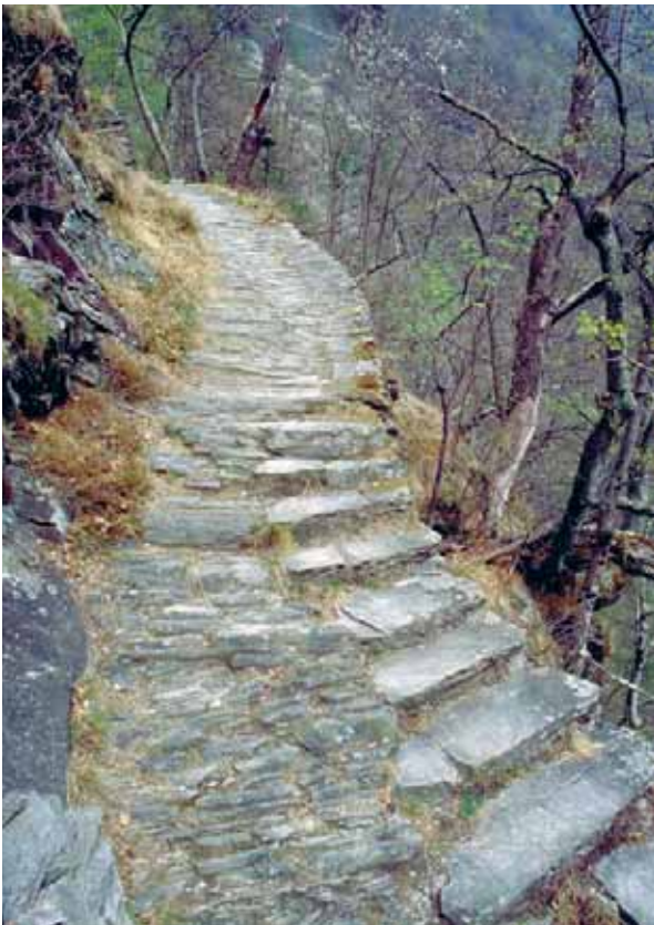
Mulattiera molto ben strutturata in un tratto ripido. Il selciato è in file di lastre posate di taglio affiancato da gradini di lastre di pietra. Tra Promontogno e Soglio GR (ViaStoria / Guy Schneider).
