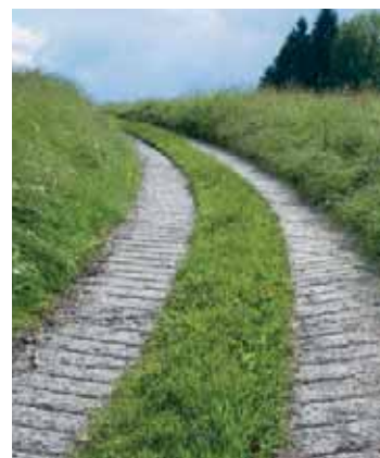
Strada agricola abilmente ristrutturata con guide in battuto di cemento, rese antiderapanti grazie a scanalature trasversali. Fahrni BE (ViaStoria / Guy Schneider).
