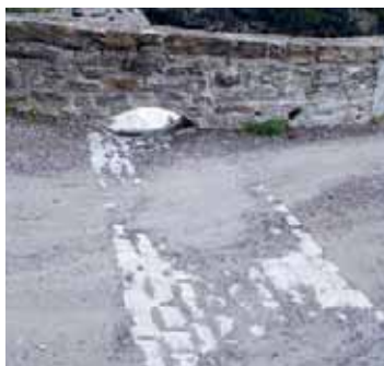
Cunetta di drenaggio lastricata su una «strada artificiale» alpina, che scarica l'acqua direttamente attraverso un'apertura ad arco del parapetto in muratura. La sede va periodicamente liberata dalla ghiaia che si accumula, proveniente dal manto stradale (ViaStoria/Arne Hegland).
