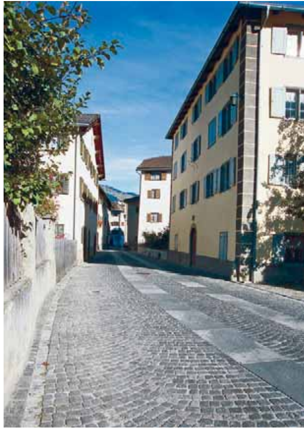
Pavé a cubetti di pietra («Bsetzi», «risciada») posati ad arco di cerchio, all'interno di un abitato. Con le due guide di lastre di pietra sul modello storico delle strade postali, il comfort di scorrimento aumenta e si riduce il rumore. Andeer GR (ViaStoria / Heinz Dieter Finck).
