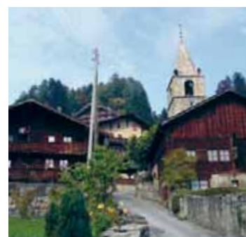
A Gryon VD, i muri di cinta delimitano lo spazio stradale e sottolineano la struttura del nucleo del villaggio risultante da vie, edifici e giardini (ViaStoria/Andriu Maissen).
