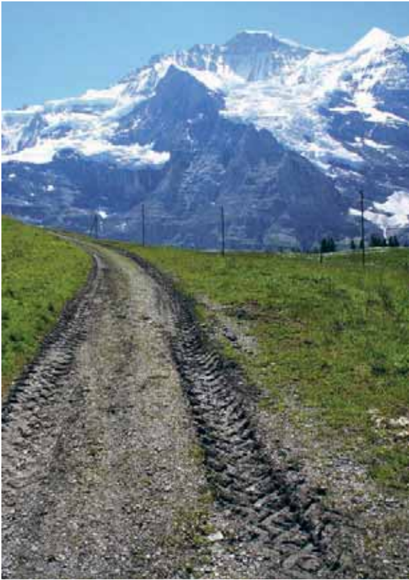
Materiale naturale: una via ad uso agricolo con fondo in terra e sabbia. Wengernalp BE (ViaStoria/Guy Schneider). Cfr. p. 51.
