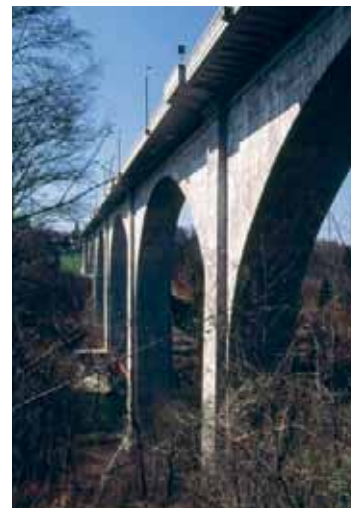
Ampliamento ben realizzato. La piattaforma stradale a sbalzo del viadotto di Péroilles a Friburgo FR, con mensole e parapetti è stata progettata ex novo come la cappella contemporanea (ViaStoria / Cornel Doswald).
