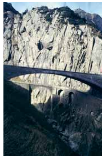
Decongestionamento con una nuova costruzione. Il Ponte del Diavolo sulla strada del Gottardo del 1830 non era più adeguato al traffico automobilistico, da cui fu sgravato con la costruzione del nuovo ponte stradale del 1955/56. Gola della Schöllenen UR (ViaStoria/ Cornel Doswald).
