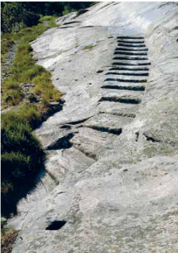
Roccia: i gradini intagliati facilitano il passaggio su una roccia granitica lisciata dal ghiacciaio. «Hälenplatte» sulla mulattiera del Grimsel, Guttannen BE (ViaStoria/Guy Schneider).
