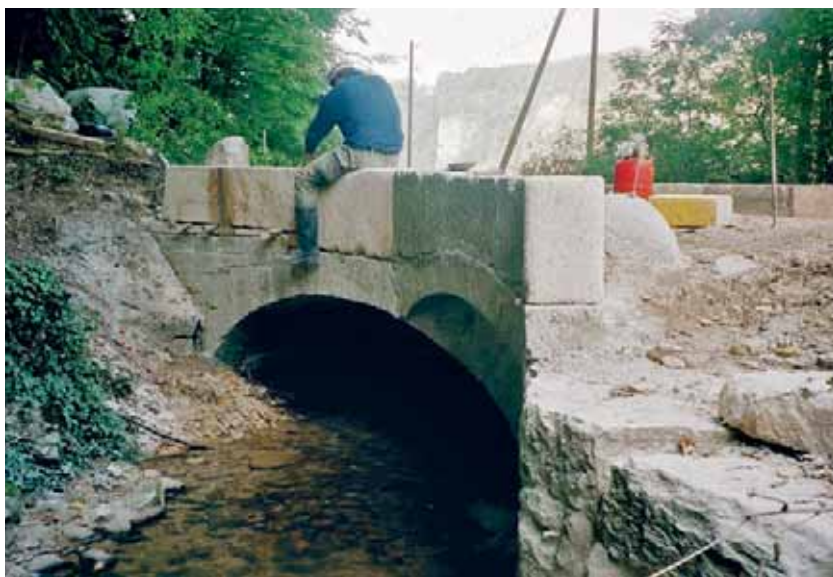
Restauro. Il ponte stradale sul Homburgerbach presso Läuelfingen BL, costruito nel 1810, è stato restaurato nel 2002. I conci del parapetto sono stati riassetati e alcuni sostituiti. Oggi il ponte è parte di una via agricola, segnalata anche come pista ciclabile (ViaStoria/ Eneas Domeniconi).
