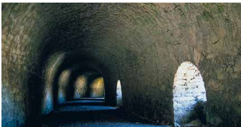
Raro esempio di galleria paravalanghe del XIX secolo: volta a botte a file di conci, aperture con archi a tutto sesto in pietre lavorate. Passo dello Spluga GR (ViaStoria/Arne Hegland).
