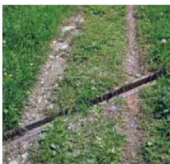
Canaletta trasversale di metallo. Benché il materiale sia estraneo alle vie tradizionali, un impiego dosato di questo tipo di canalette, che si inseriscono con discrezione nell'ambiente, può essere preso in considerazione anche per le vie storiche (ViaStoria/Guy Schneider).
