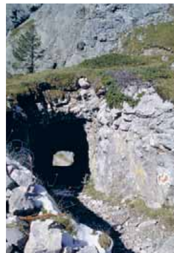
Il traforo di questo semplice tunnel non rivestito nella roccia cristallina risale al restauro nel XIX secolo della mulattiera di Rawil, sul lato vallesano (ViaStoria/ Vanessa Bitz).
