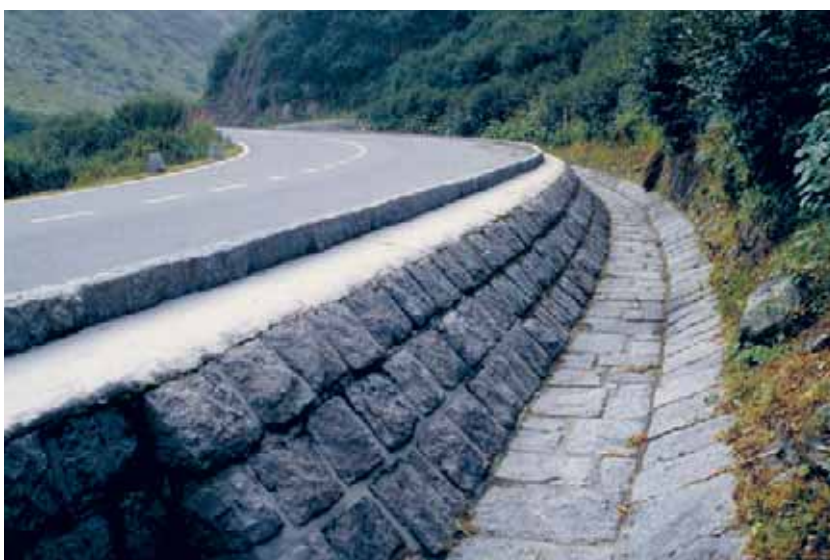
Fosso laterale rivestito di blocchi di pietra squadrati e cementati. La forma rigidamente geometrica non rende giustizia alla strada storica. Strada del Gottardo UR (ViaStoria/Arne Hegland).
