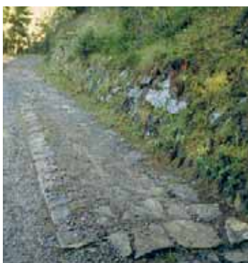
Per renderla carreggiabile, questa carrareccia è stata allargata e il lastricato è stato inghiaiato. Alpnach OW (ViaStoria/ Guy Schneider).
