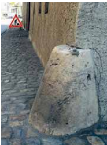
Paracarro in calcare del Giura, lavorato e inserito nell'angolo di una casa a Thun BE (ViaStoria / Guy Schneider).
