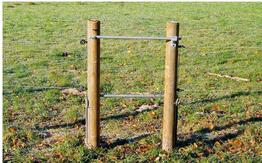
Fig. 69 Passaggio lungo una recinzione elettrica. La corrente passa attraverso un cavo isolato che viene fatto scorrere sotto il passaggio
