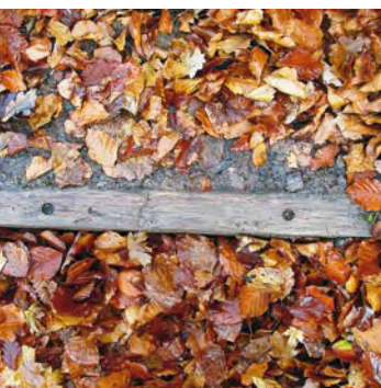
Fig. 56 Gradino con fori trivellati per il fissaggio del ferro di armatura
