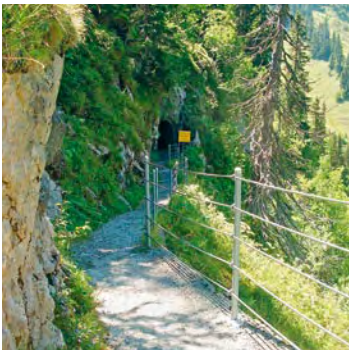
Fig. 61 Parapetto di metallo
