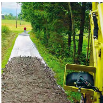
Fig. 20 Lo strato di fondazione viene posato dal davanti
