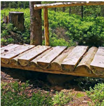
Fig. 50 Piano di calpestio con pali di legno dimezzati
