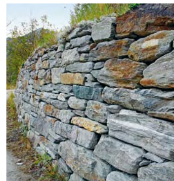
Fig. 82 Muro a secco
