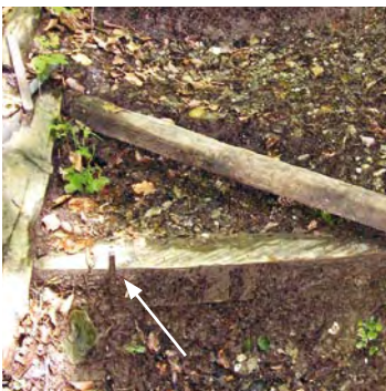
Fig. 86 Ferro di armatura sporgente
