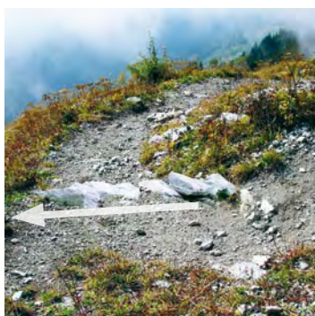
Fig. 26 Drenaggio nel punto di svolta
