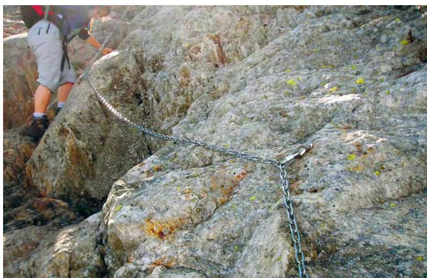
Fig. 63 Corrimano realizzato con una catena zincata
