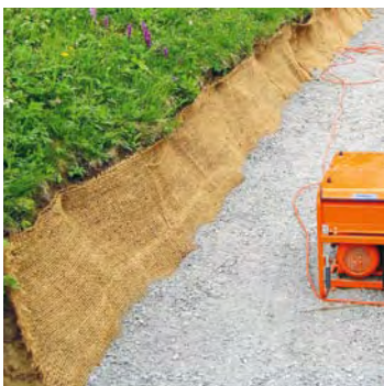
Fig. 76 Stuoie di juta proteggono la scarpata dall'erosione durante i lavori
