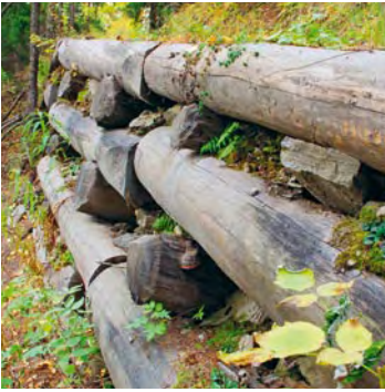
Fig. 79 Palificata di sostegno
