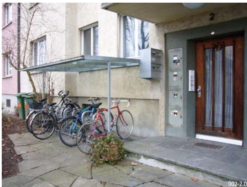
Posteggio coperto, in prossimità dell'ingresso e con possibilità di legare il telaio
