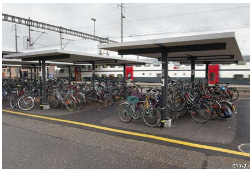
Posteggio in prossimità dei binari, coperto e illuminato
