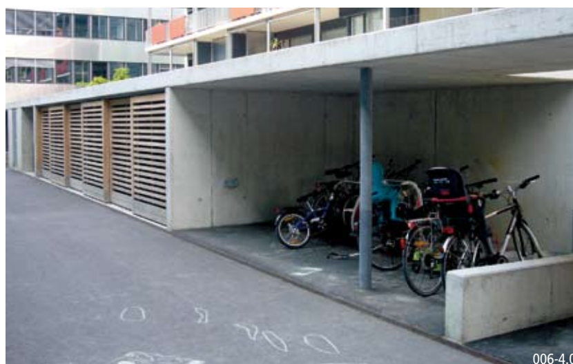
Soluzione combinata di impianto chiuso (a sinistra) e impianto aperto
