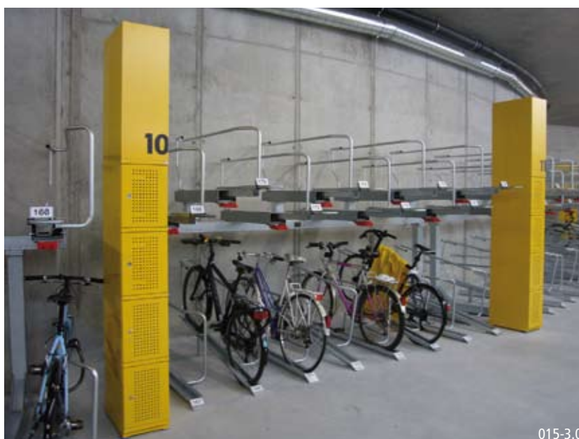
Parcheggio su due livelli per uno sfruttamento ottimale dello spazio, completo di cassette di sicurezza
