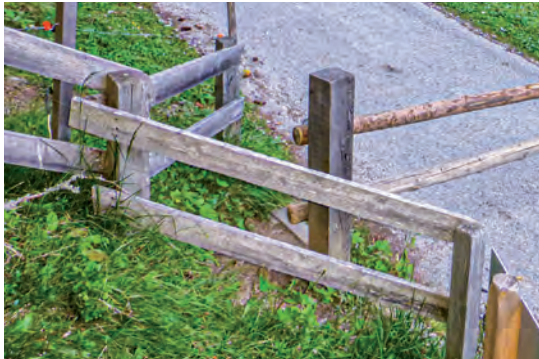
Dreieckdurchgang neben Fahrstrasse
