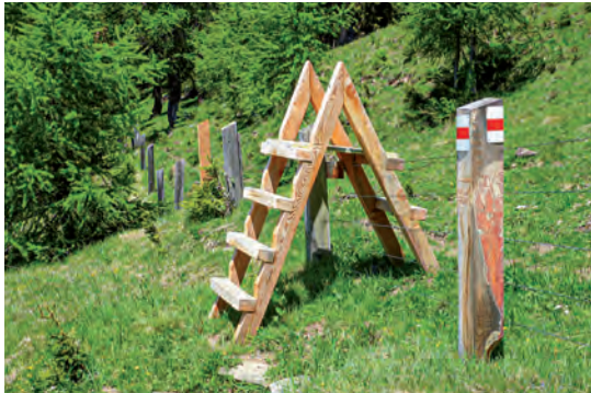
Bockleiter aus Holz über Dreifach-Drahtzaun
