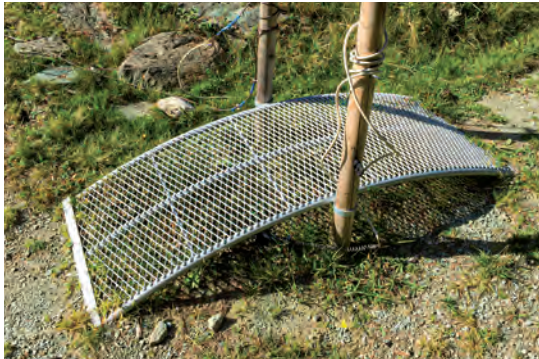
Giterrampe in Bogenform mit angeflanschten Pfahlhalterungen
