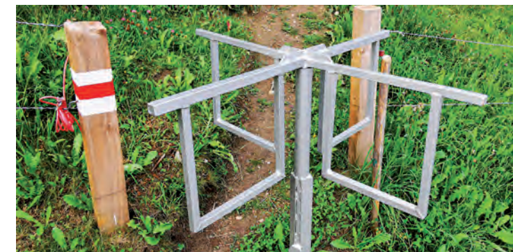
Das Drehkreuz gewährleistet den ausschliesslichen Durchlass für Zufussgehende
