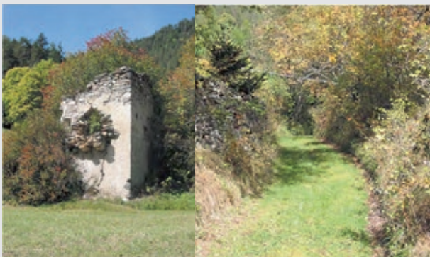
Cha Noschas – Gebäude ruine mit Backofen / Strassenzug
