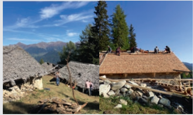
Maiensässe auf Chant Sura; rechts kurz vor der Fertigstellung
