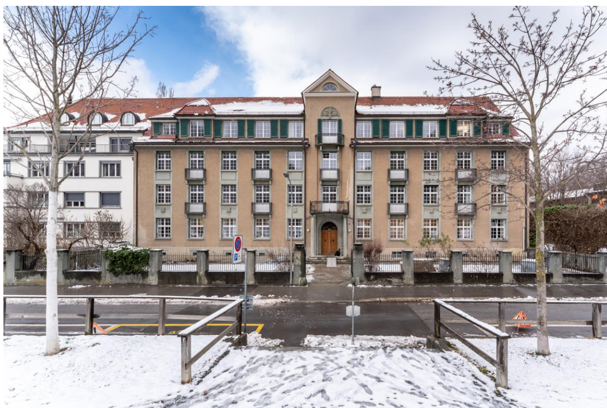
Bild: Neuer Hauptsitz Staatsanwaltschaft in Chur, Rohanstrasse 5.
