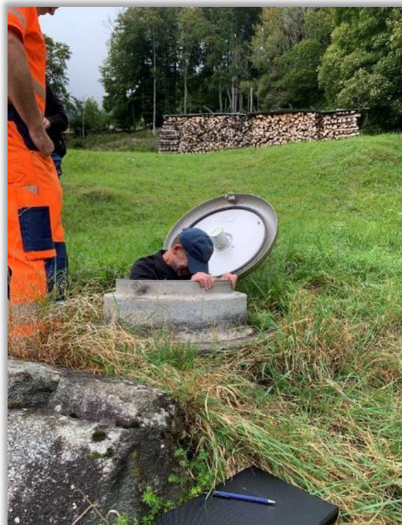
Foto: © ALT - Kontrolle einer Brunnenstube
