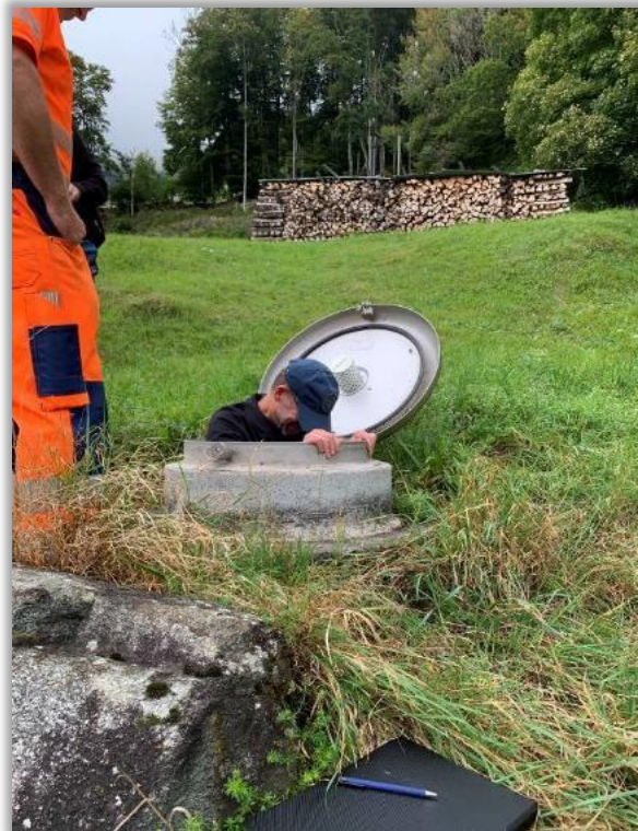
Foto: © ALT - Kontrolle einer Brunnenstube
